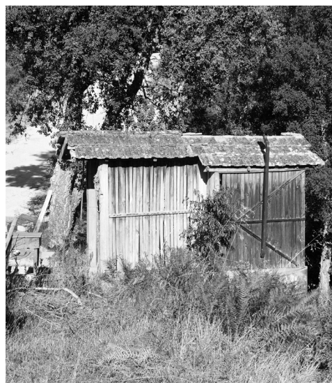
Fig. 63: Casa de banho de compostagem orgânica construída aproveitando a estrutura dum antigo espigueiro.
