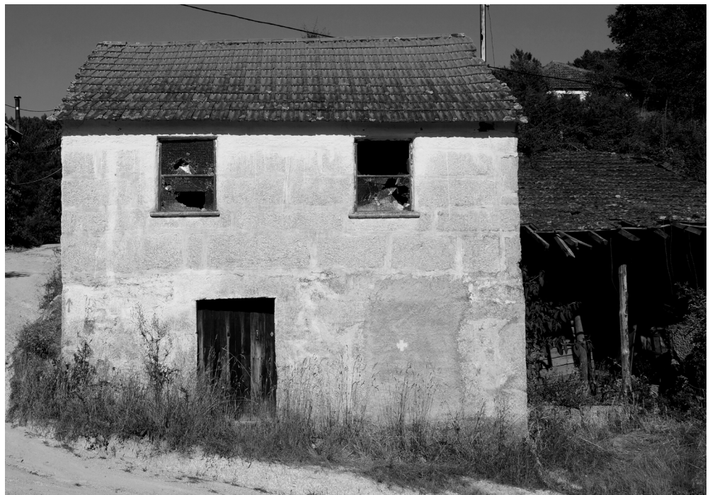
Fig. 34: Vista do alçado oeste.
