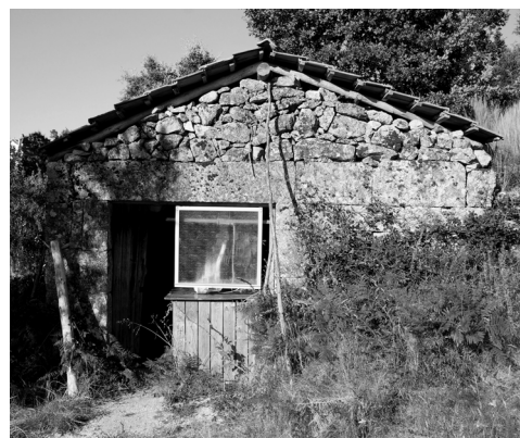
Fig. 31: Vista do alçado oeste.
