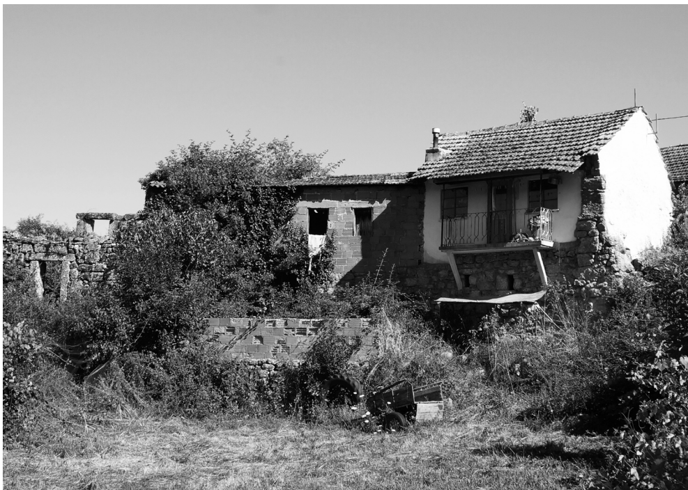
Fig. 27: Vista dos alçados sul e este. A direita, casa comunitária atualmente habitada pela Cheila.
