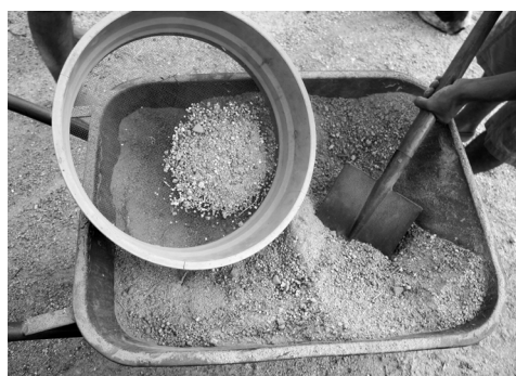
Fig. 64: Peneirado da areia para reboco da Sala Comum.
