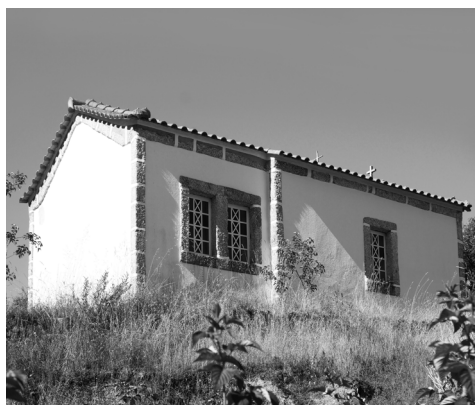
Fig. 56: Vista do alçado oeste. Fig. 57: Vista dos alçados este e norte.
