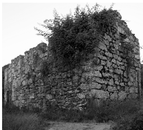
Fig. 22: Vista do alçado este. Fig. 23: Vista dos alçados norte e oeste.
