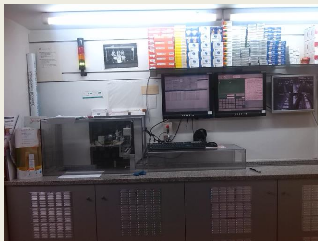
Painéis de controlo, passadeira e entrada do robot.
