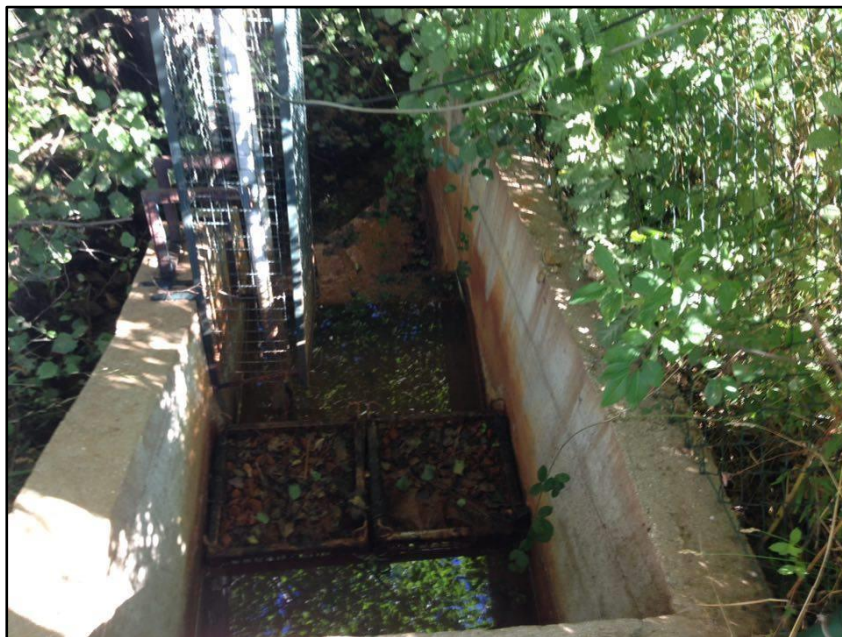
Figura 24. Canal de saída da água tratada para a ribeira de Peliteira
