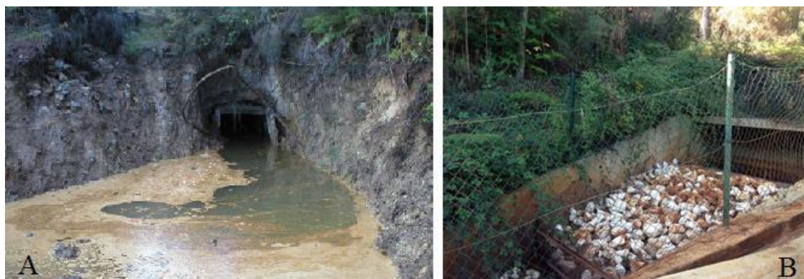
Figura 18. Boca da galeria da mina de Jales, A)Saída de água ácida antes da intervenção feita pela EDM(Fontes: EDM, 2011) B) Saída de água ácida após intervenção e implementação de escadas de arejamento com calcário.
