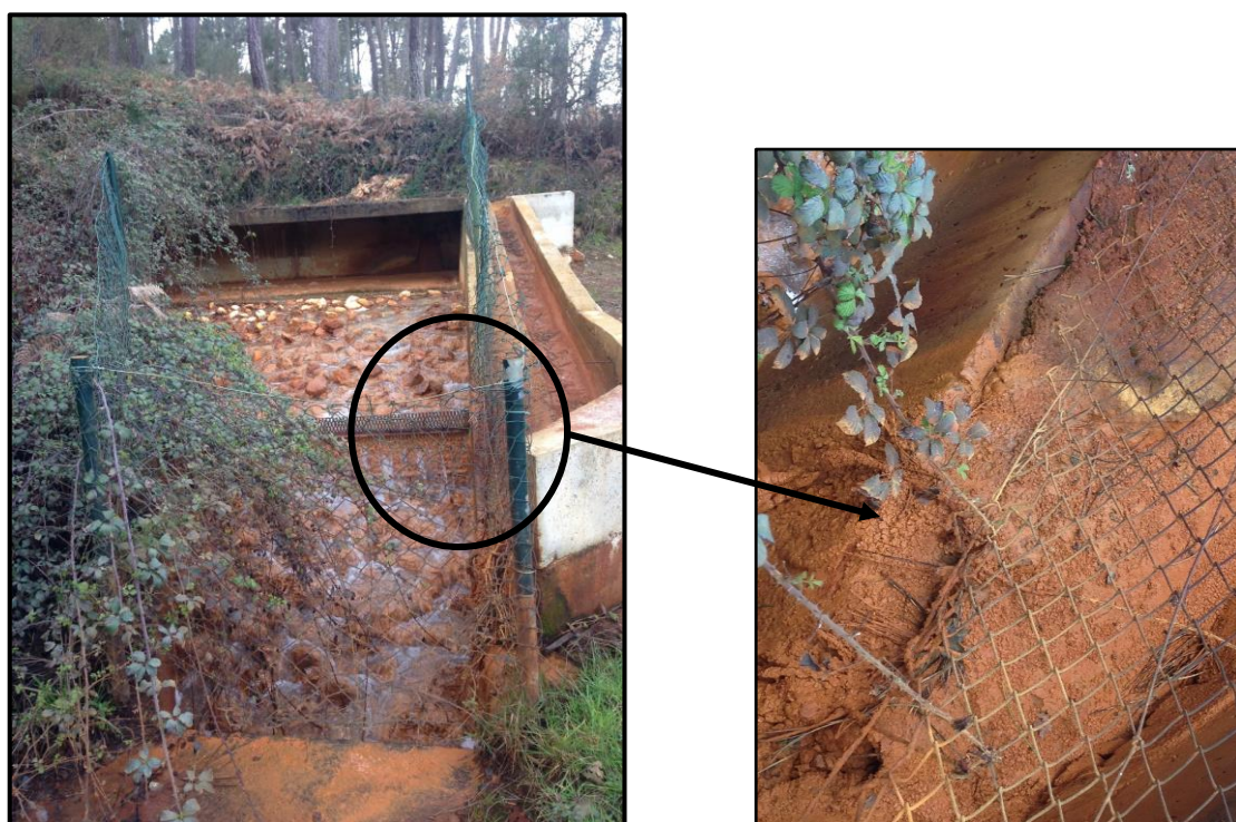
Figura 25. Escada de Arejamento da mina de Jales com ampliação da parede lateral da escada
