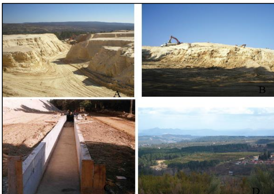
Figura 15. Intervenção na escombreira da mina de jales, A) e B) Fase de modelação e drenagem
