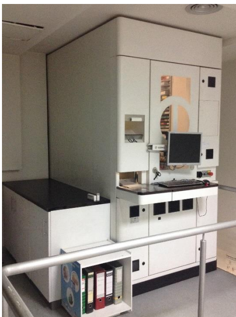
Figura 17 – Fachada exterior do robot instalado na Farmácia Lamar.
