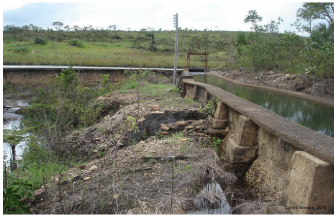
Figura 3.11: Canal de adução.
