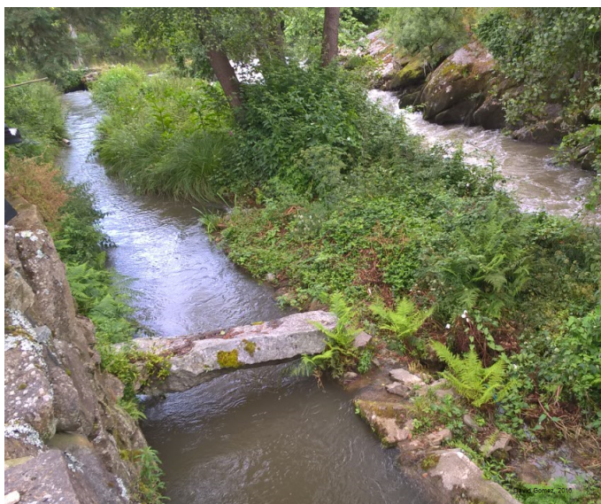
Figura 5.8: Levada existente no local.
