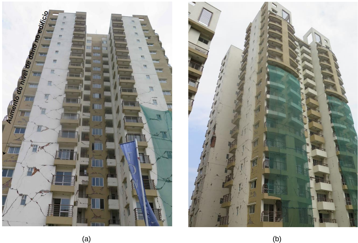
Figura 3.19 – (a) Fotografia da fachada norte do edifício; (b) Fotografia em perspectiva onde é visível parte da fachada sul e fachada este do edifício
