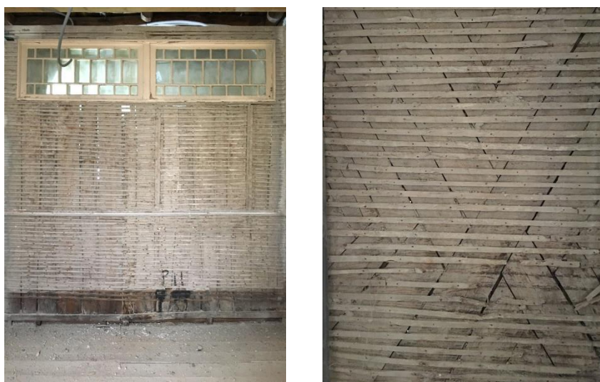
Fig. 3.8 – À esquerda: tabique Tipo A; à direita: tabique Tipo B
