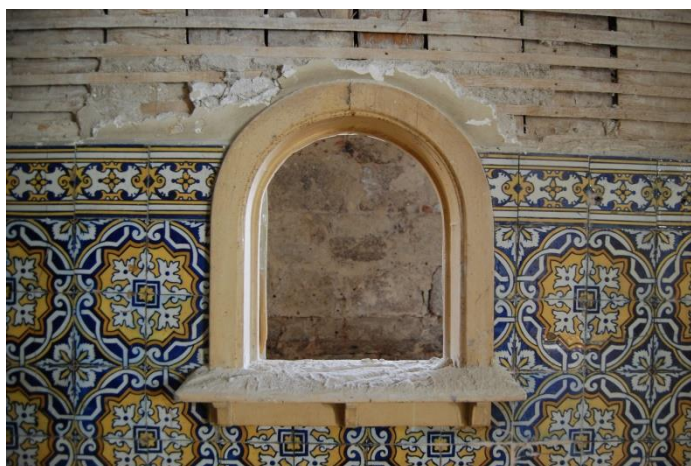
Fig. 3.9 – Revestimento de parede: azulejo sobre reboco
