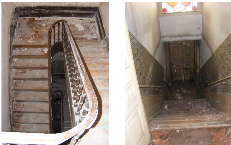
Fig. 3.17 – À esquerda: escada 1; à direita: escada 2
