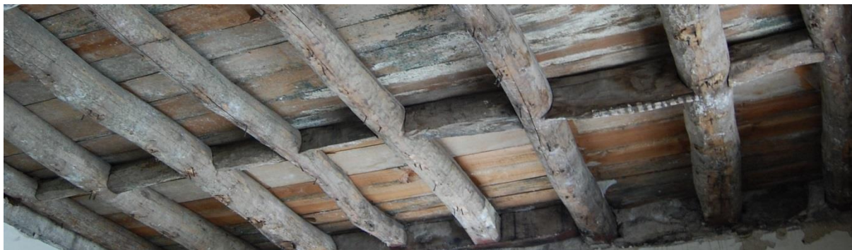
Fig. 3.25 – Tarugos com secção variada
