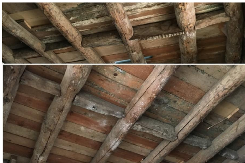
Fig. 4.17 – Tarugos do pavimento em estudo, com secções variadas
