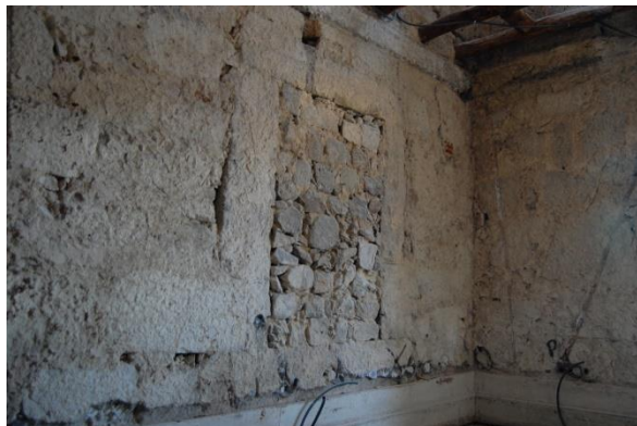
Fig. 3.7 – Parede de meação; tapamento de uma janela
