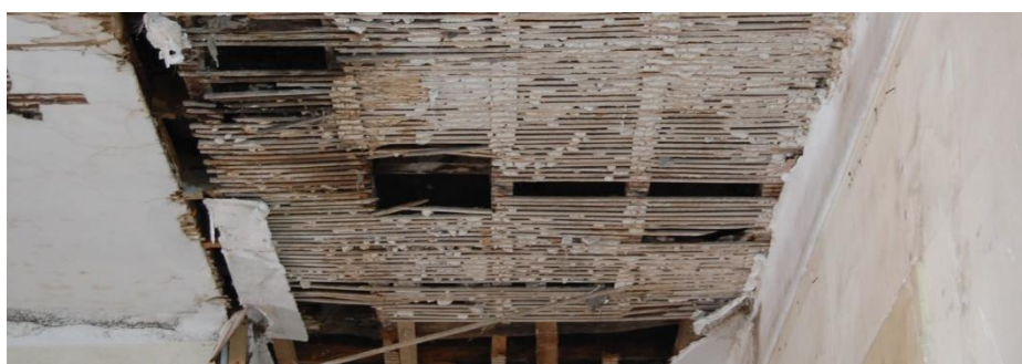
Fig. 3.14 – Teto em demolição
