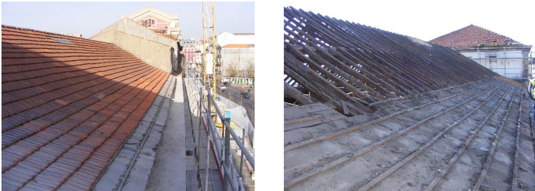
Fig. 3.16 –À esquerda: cobertura completa; à direita: cobertura despida , com as varas, o guarda-pó e as ripas visíveis
