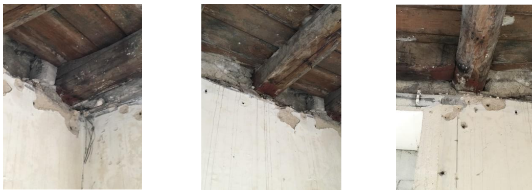
Fig. 4.13 – Apoio das vigas V1, V2 e V3 no alinhamento A
