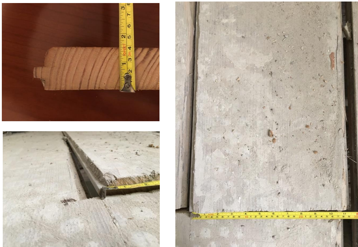
Fig. 4.18 – À esquerda: em cima, espessura das tábuas; em baixo, tipo de encaixe entre tábuas. À direita, largura das tábuas
