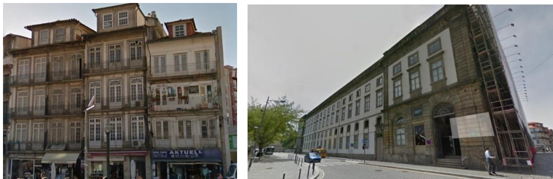
Fig. 2.1 – À esquerda: edifícios antigos correntes, fachada confrontante com a rua Mouzinho da Silveira; à direita: edifício antigo nobre; fachada confrontante com a rua Dr. Ferreira da Silva
