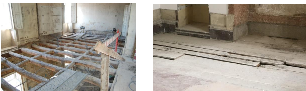
Fig. 3.12 – À esquerda: vigamento de madeira em pau rolado; à direita: soalho
