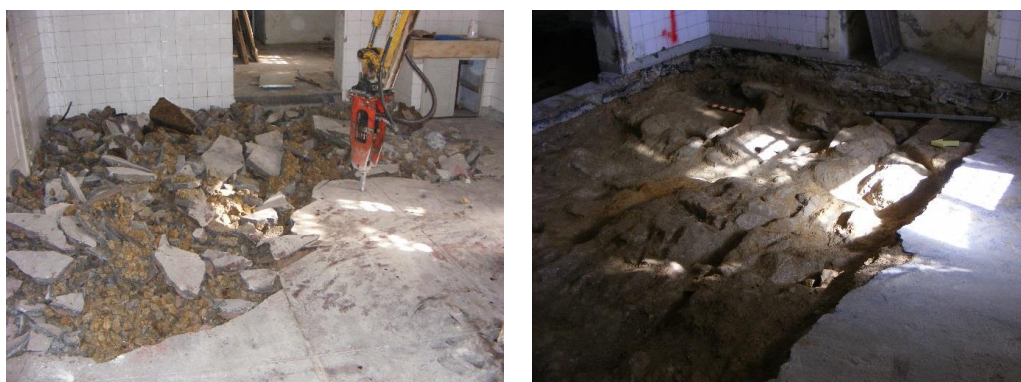
Fig. 3.20 – À esquerda: levantamento do pavimento térreo da Torre Sul; à direita: solo de fundação (maciço rochoso)
