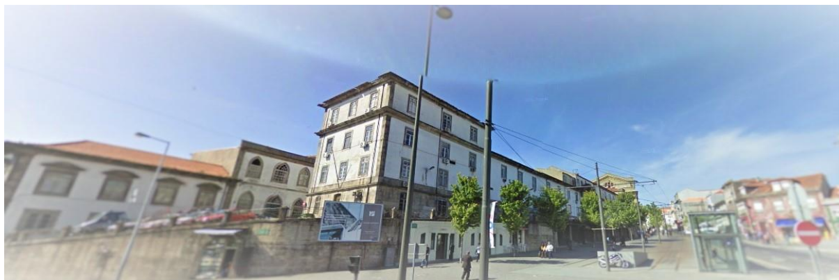
Fig. 3.1 – Edifício DISTRICT, vista de sudeste
