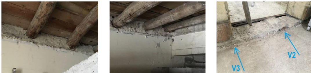
Fig. 4.16 – À esquerda: apoio das vigas V4 e V5 (alinhamento B); ao centro: apoio das vigas V6, V7 e V8 (alinhamento B); à direita: apoio das vigas V1 (não visível), V2 e V3 (alinhamento C)
