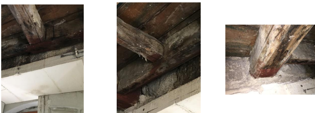
Fig. 4.14 – Apoio das vigas V4, V5 e V6 no alinhamento A
