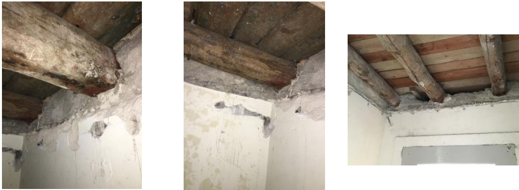
Fig. 4.15 – À esquerda: apoio da viga V7 (alinhamento A); ao centro: apoio da viga V8 (alinhamento A); à direita: apoio das vigas V1, V2 e V3 (alinhamento B)
