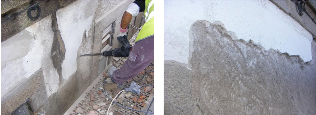
Fig. 3.6 – À esquerda: trabalhos na parede de fachada (exterior) ; à esquerda: confirmação da camada de reboco existente (exterior)
