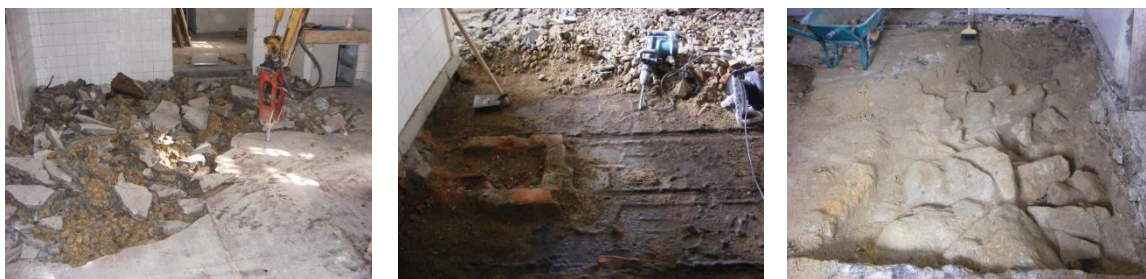
Fig. 3.10 – À esquerda: levantamento do pavimento térreo; ao centro: camada betuminosa; à direita: solo de fundação
