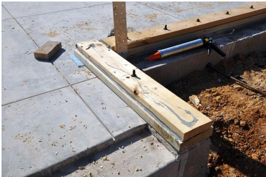
Figura 57 Fixação das calhas as fundações (Borson 2014)
