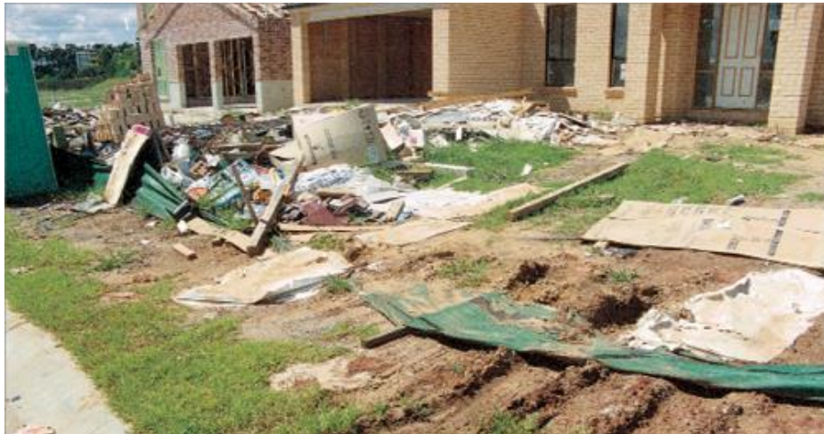
Figura 31 Exemplo do desperdício num local de construção (Reardon and Fewster 2013)
