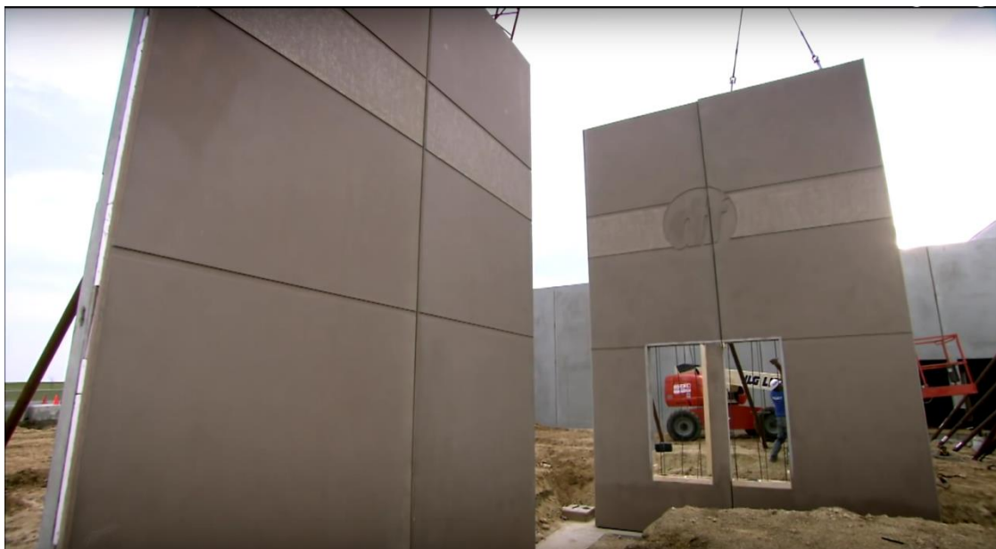
Figura 22 Parede construída com painéis de betão (Channel 2015)
