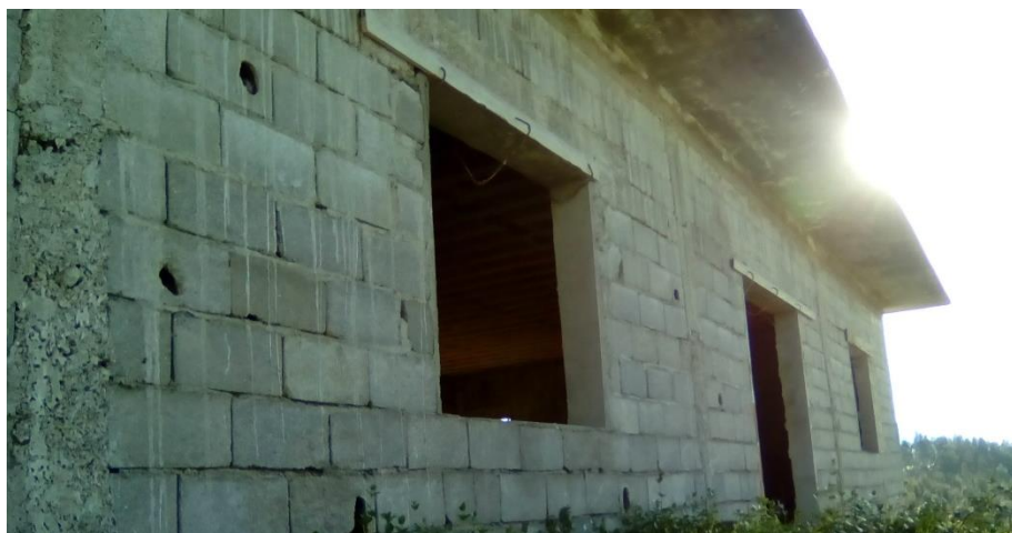
Figura 11 Construção local em bloco de betão
