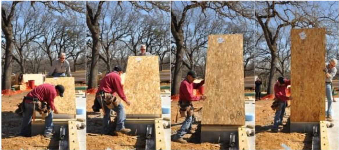
Figura 58 Colocação do painel na calha (Borson 2014)
