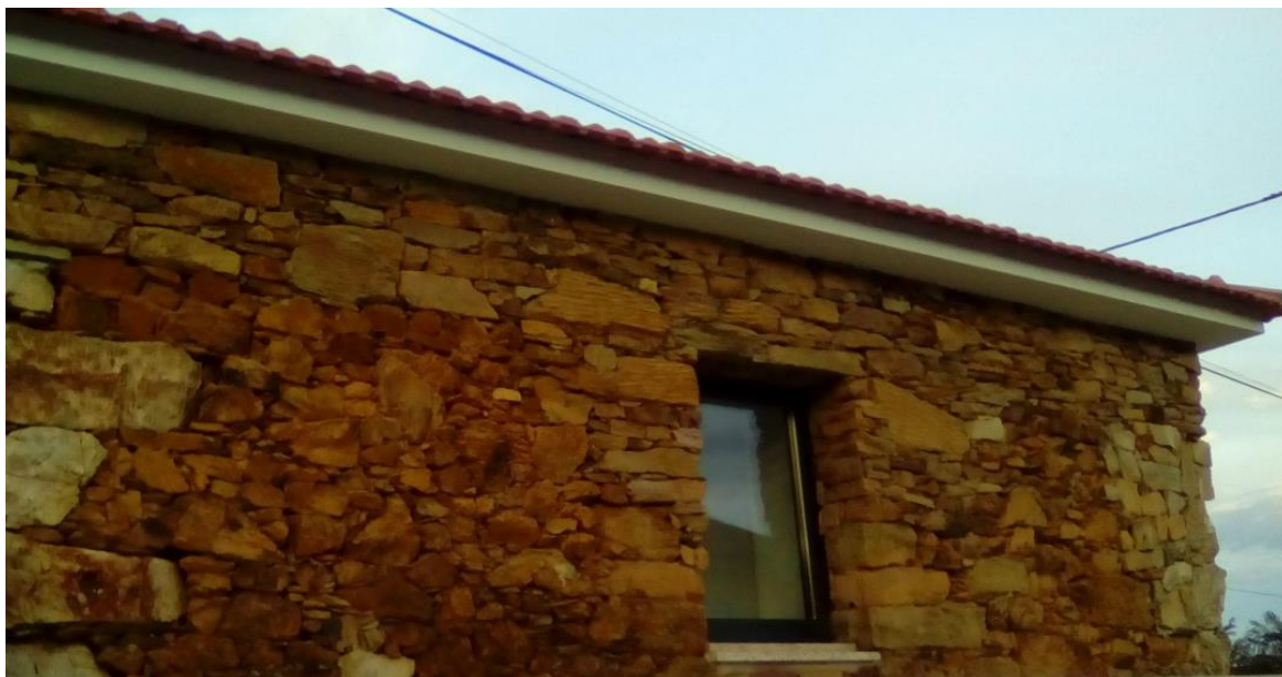
Figura 8 Construção local com paredes em alvenaria de pedra
