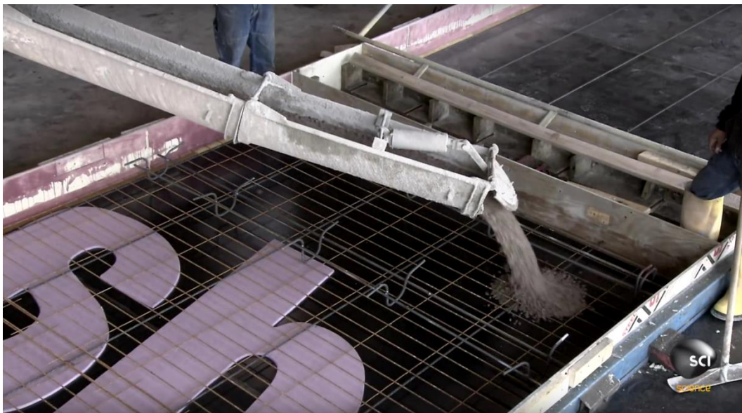
Figura 20 Início do vazamento de betão no molde armado (Channel 2015)
