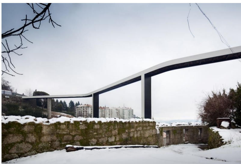
Figura 2.2 – Ponte da Ribeira da Carpinteira, Covilhã
