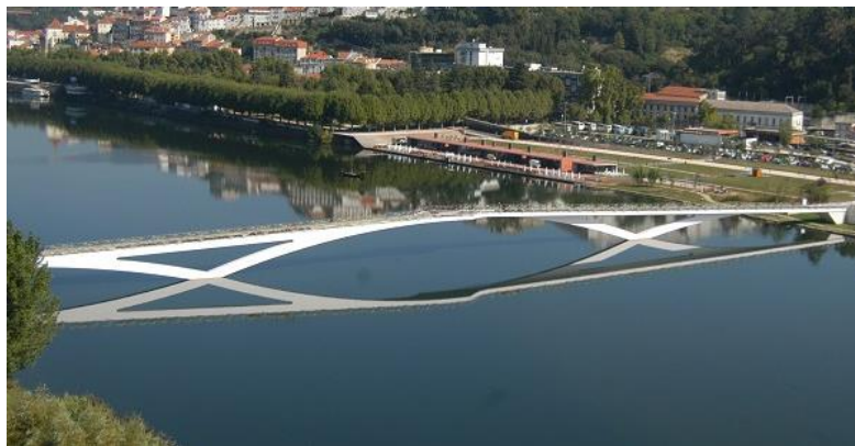
Figura 2.5 – Ponte Pedonal Pedro e Inês, Coimbra
