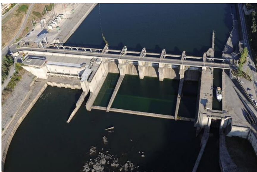
Figura 2.4- Barragem da Régua com a sua eclusa de navegação (Fonte: EDP).
