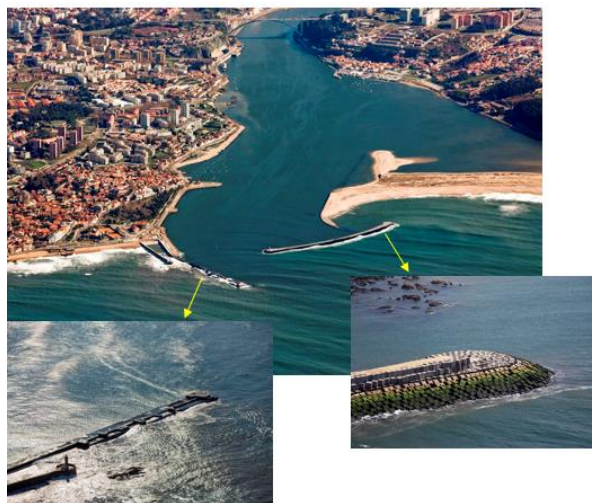
Figura 2.10- Embocadura do estuário do Douro com pormenores do quebramar destacado e do molhe Norte (Adaptado de Irmãos Cavaco S.A, 2016).
