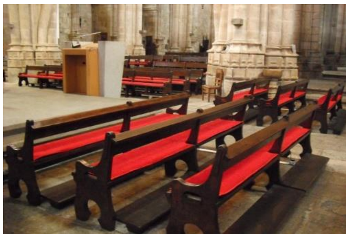
Fig. 4.22 – Aquecimento dos bancos do tipo almofada na Sé de Viseu [50]
