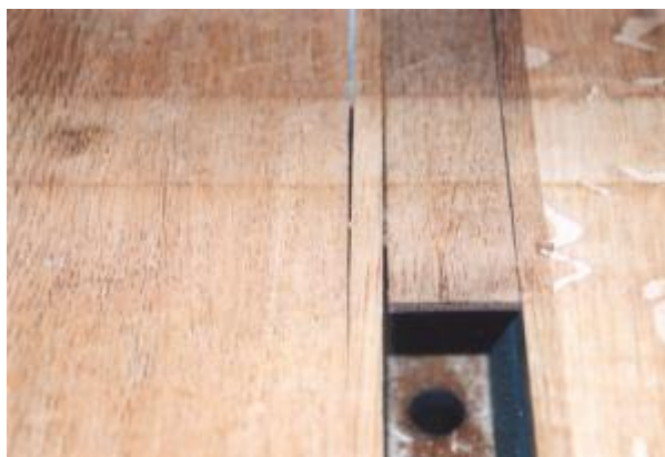
Fig. 5.15 – Encaixe da gaveta do vento do órgão monumental [10]
