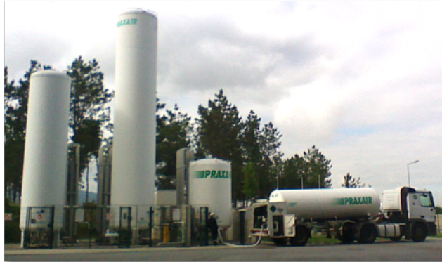
Figura 5 - Enchimento de tanques de gases medicinais.
