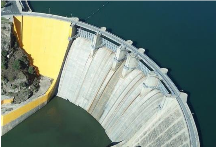
Figura 2.2 – Barragem de Bemposta, sistema de dissipação por ressalto hidráulico [1].
