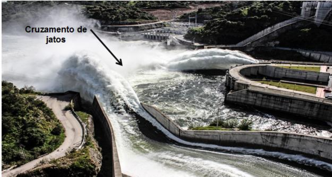
Figura 2.16- Barragem do Alqueva, sistema de dissipação por jatos cruzados [5].
