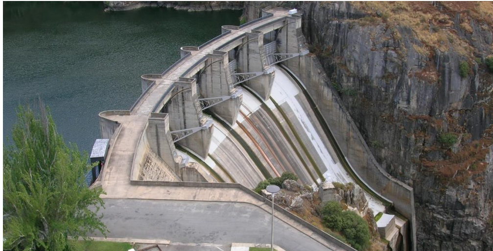
Figura 2.14- Barragem de Picote, sistema de dissipação por salto esqui [4].
