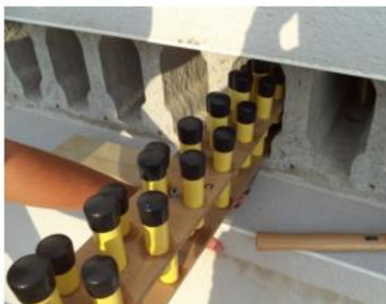
Figura 3.2. – Colocação de PCM macro encapsulado em laje aligeirada (Navarro et al., 2015)
