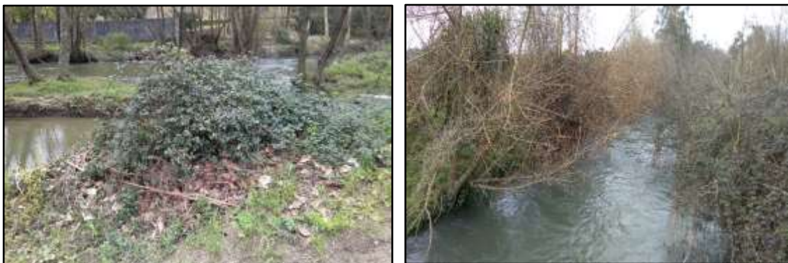
Figura 6.1: Acumulação excessiva de vegetação no local B e no local C.
