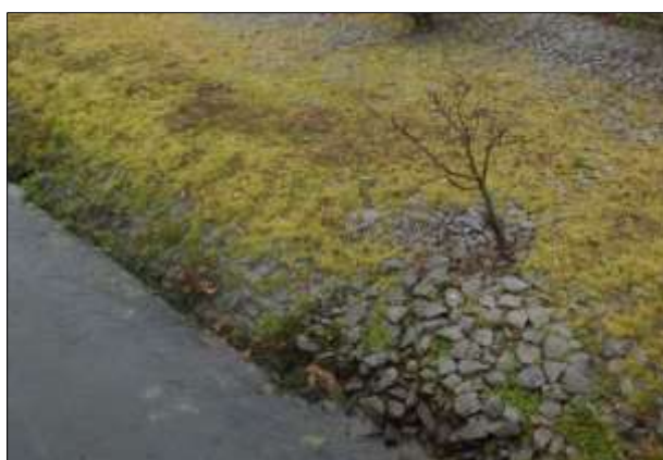
Figura 6.6: Enrocamento existente numa das margens do local D.
