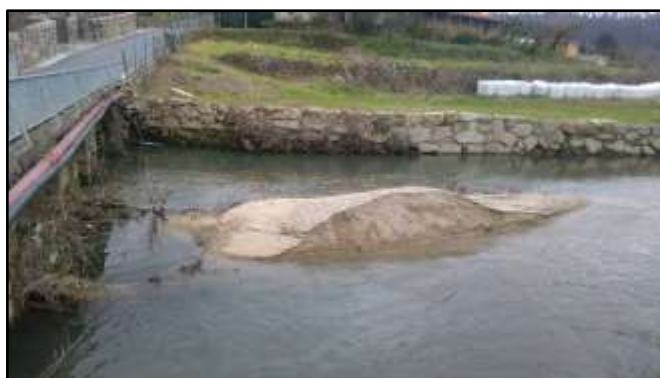
Figura 6.2: Acumulação de sedimentos existente no local A no dia 23/02/2016.
