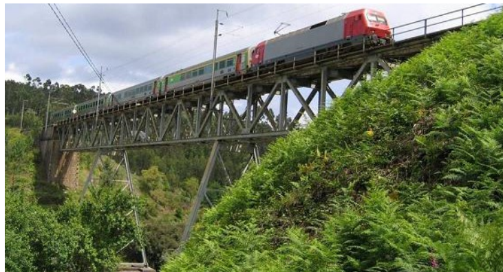
Figure 5.1 – The Trezói bridge.
