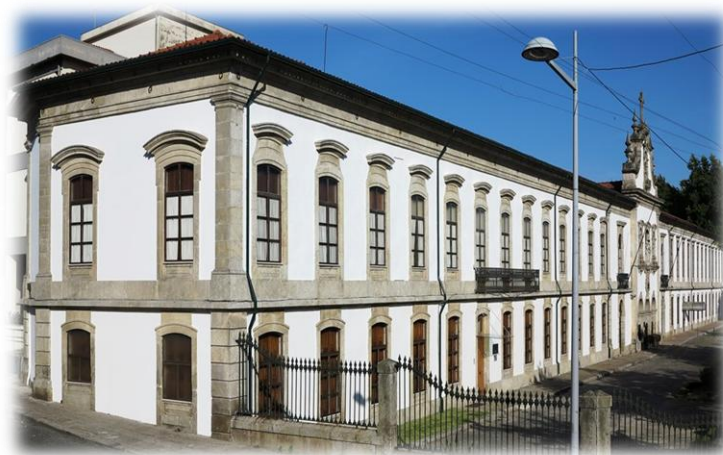
Figura 11 – Edifício sede: Serviços Centrais e Lar da Misericórdia
