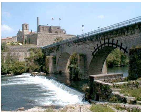
Figura 12 – Ponte sobre o rio Cávado em Barcelos
