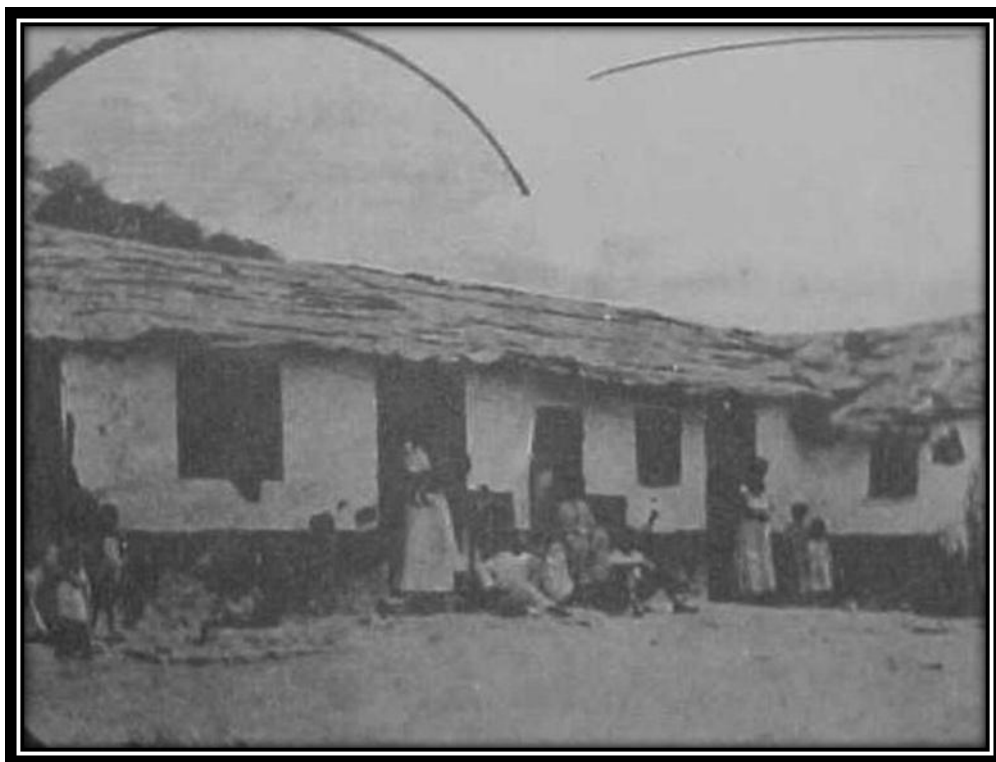
Figura 11. As primeiras casas no Morro da Providência em 1905
