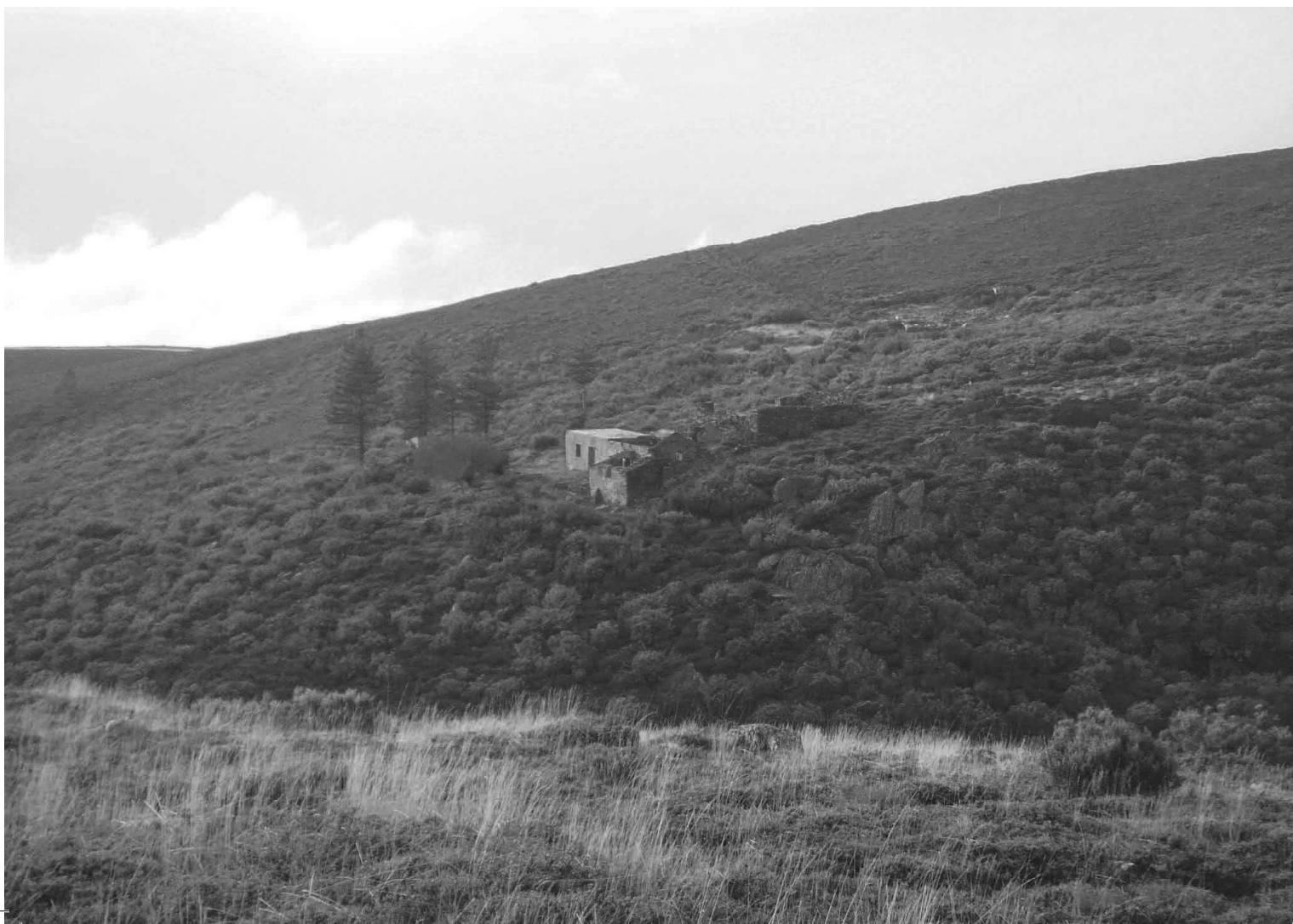
Fig. 2.10 - Mina do Penedo Ruivo (Serra do Marão).
