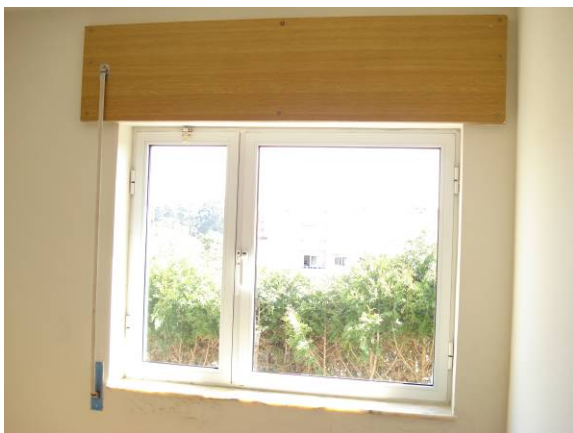
Fig. 16 - Janela com caixa de estore visível.
