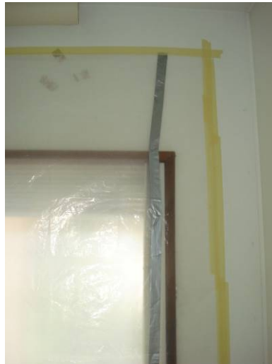
Fig. 28 - Selagem da janela.
