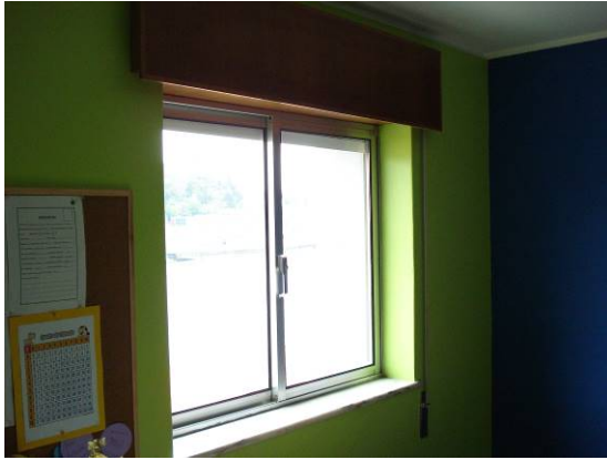
Fig. 22 - Janela com caixa de estore visível.
