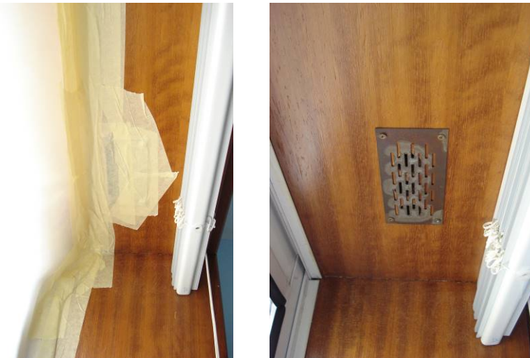
Fig. 46 - À esquerda a grelha selada e à direita a grelha sem ser selada.
