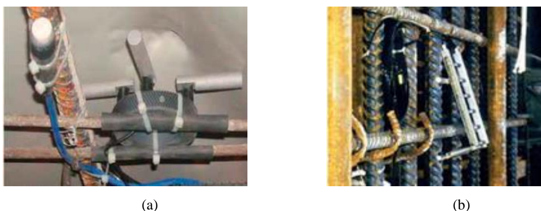
Figura 2.13: Aplicação dos sensores em obra: a) Sensor CorroWatch; b) Sensor Escada.
