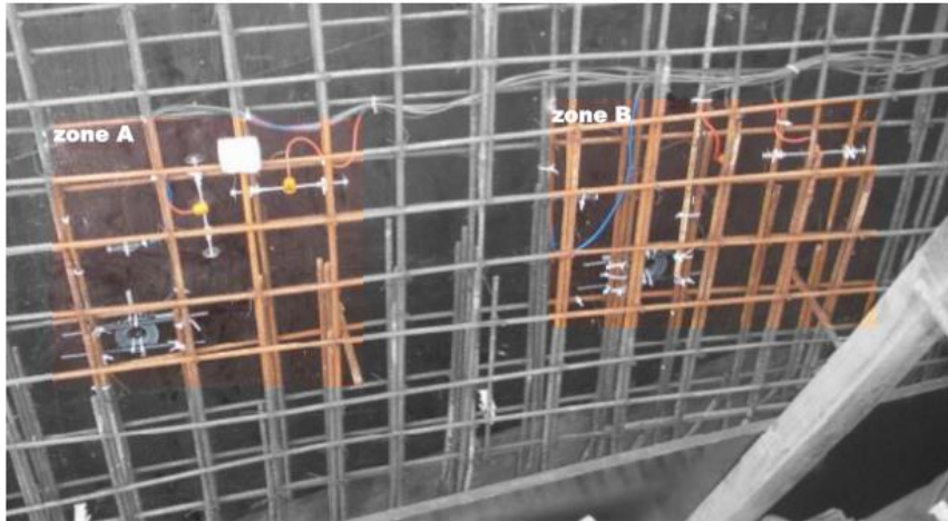
Figura 4.15: Instalação do kit-sensor de corrosão na Parede Curva [108].
