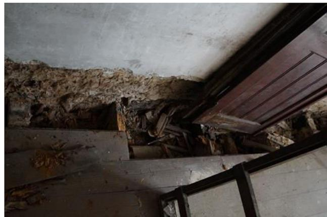
Figura 2.11 – Dano numa viga de madeira (perda de secção da viga) provocado por ataque biótico (fotografia da autora, 2016)
