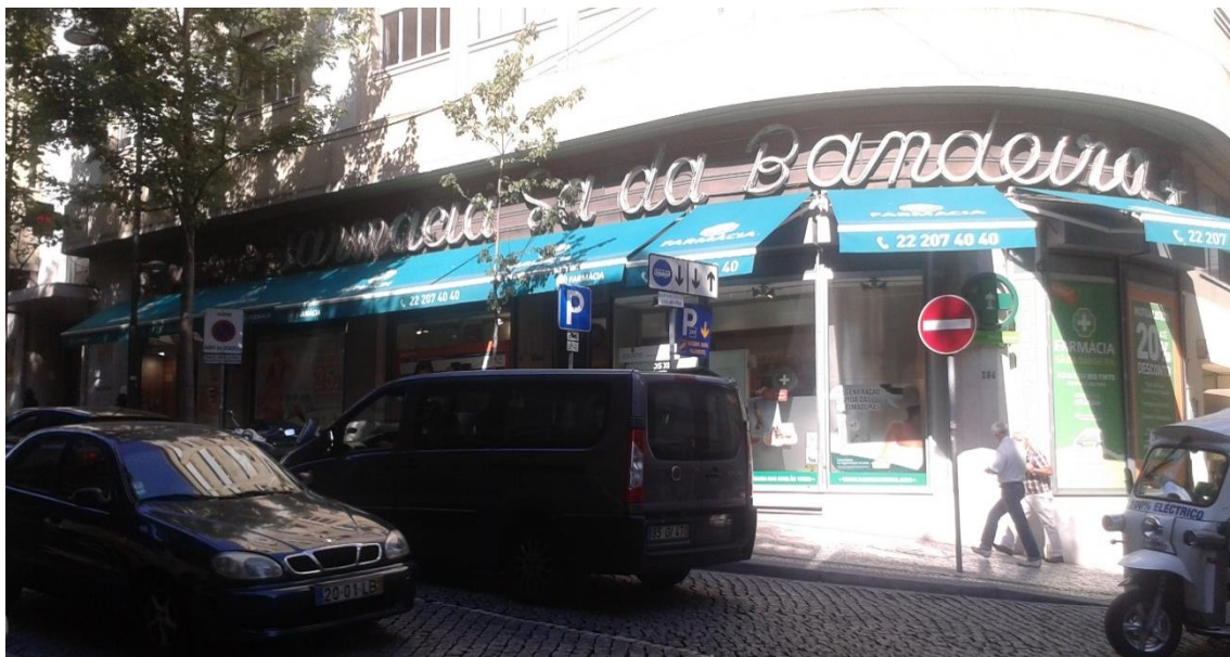
Figura 1 – Fachada exterior da Farmácia Sá da Bandeira – Porto
