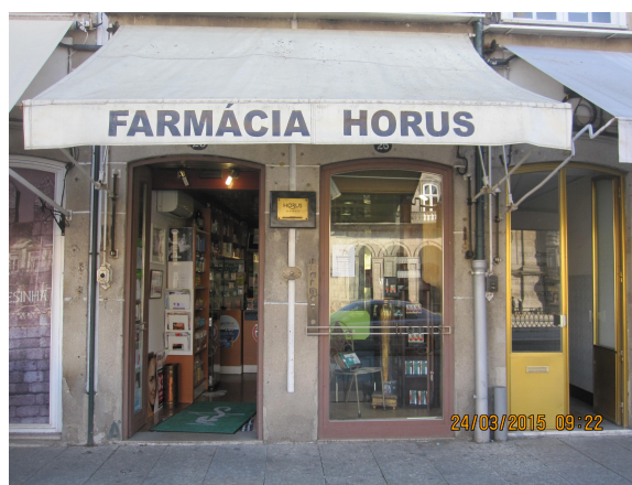
Figura 6 - Fachada exterior FH;
