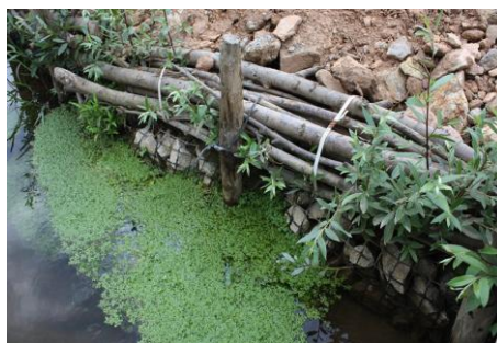
Fig.66 - Consolidação e recuperação de margens com Faxinas.
