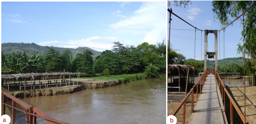
Fig.55 - Vistas sobre a margem direita a partir da ponte pedonal
