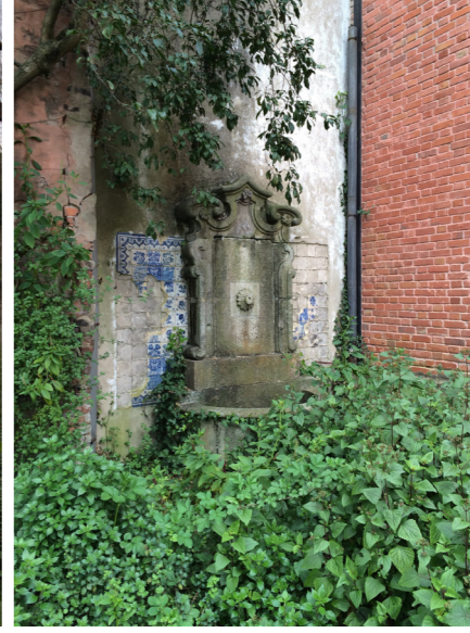
28- pequeno fontanário adjacente a fachada sul do volume B
