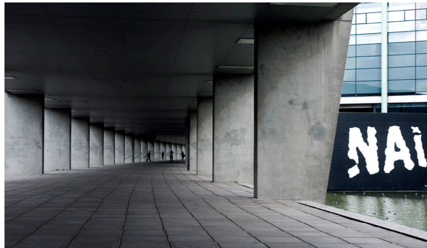
17- galeria exterior NAI
