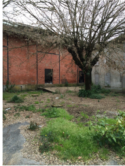
17- pátio interior em conformidade com a pré-existência
