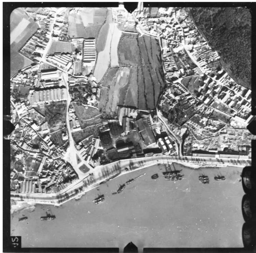
13- fotografia aérea da zona ribeirinha, residencial e industrial de Lordelo do Ouro
