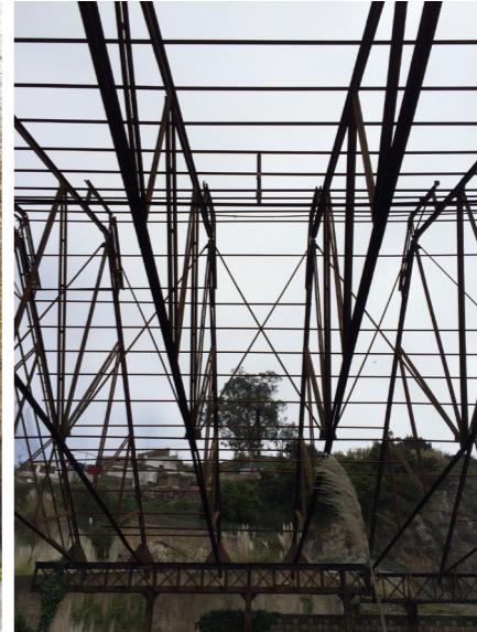
30- pormenor de cobertura
