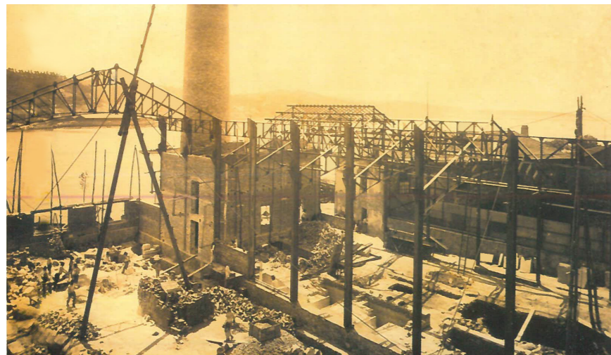
11- construção da Fábrica de Electricidade, 1907
