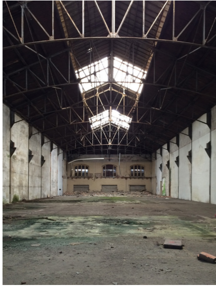
23- vista interior da nave paralela - remate da fachada sul
