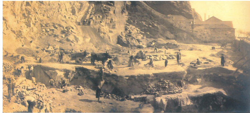
10- terraplanagem para a nova construção
