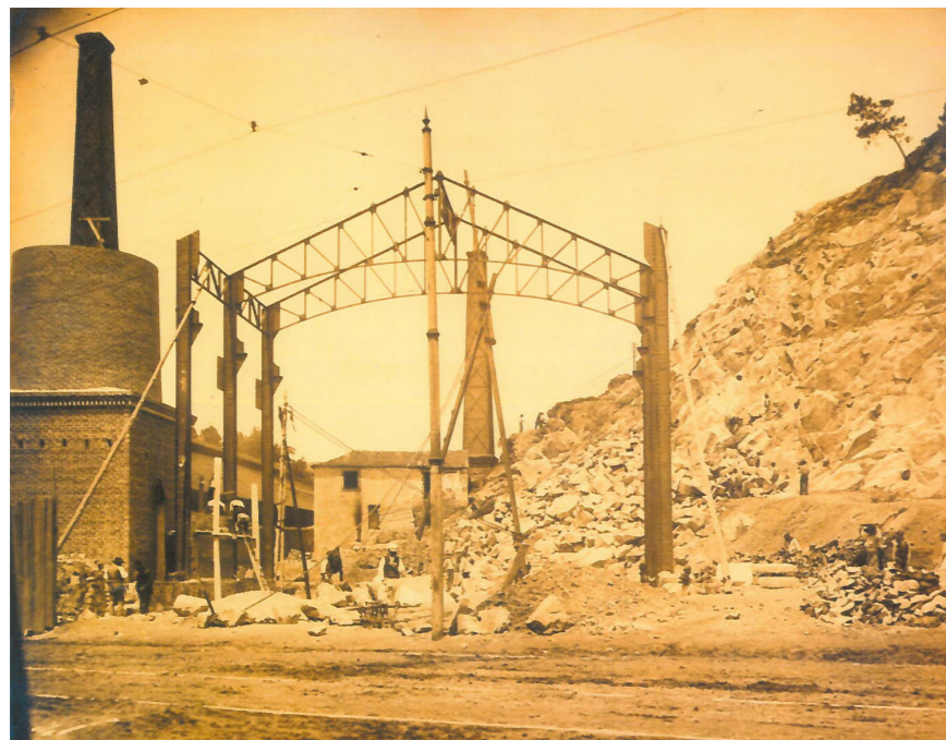
12- construção da Fábrica de Electricidade, 1907
