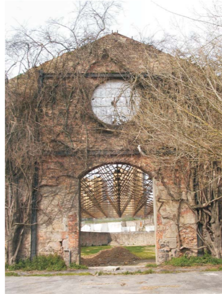
29- fachada sul do volume B
