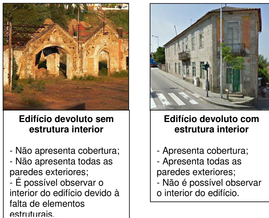
Fig. 39 – Diferenças entre edifícios devolutos sem estrutura interior (Mina de S. Domingos) e edifícios devolutos com estrutura interior (Penafiel).
