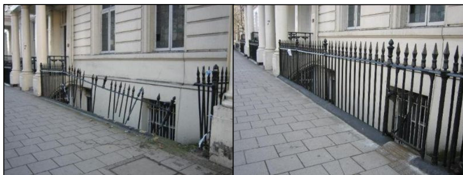
Fig. 28 – Exemplo de gradeamento em risco de queda (Esquerda) e o mesmo gradeamento arranjado (Direita) (Londres). Fonte [62]
