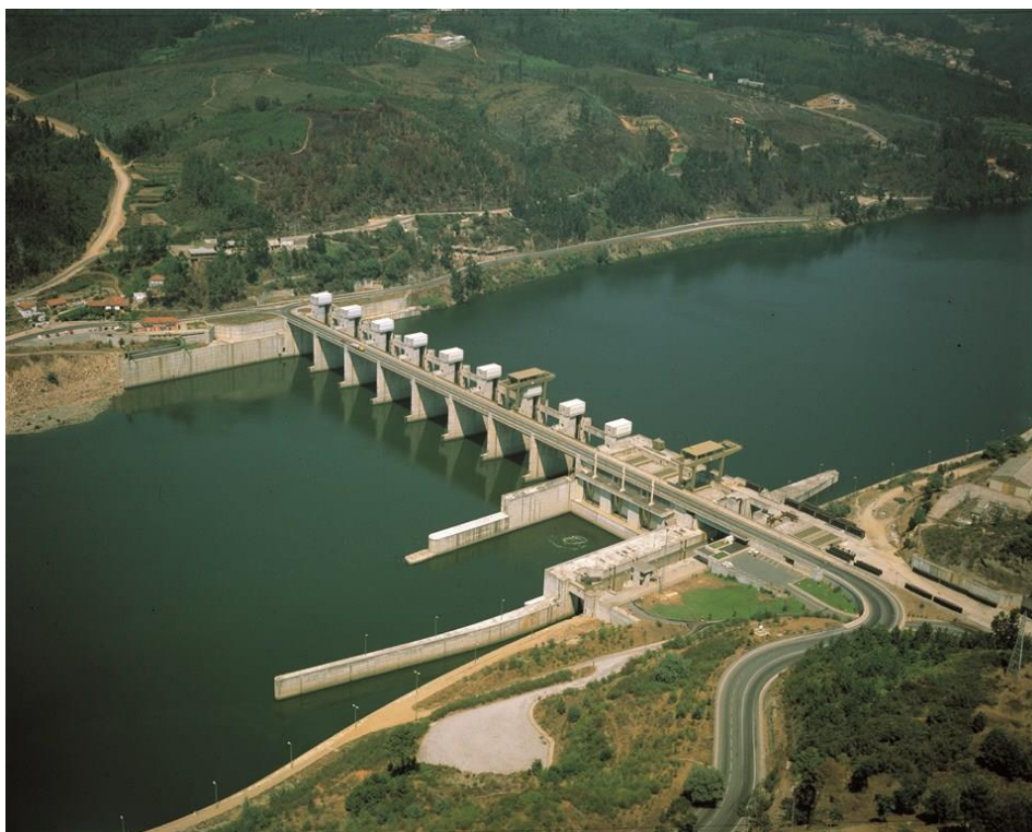
Fig. 2 – Barragem de Crestuma-Lever - vista aérea
