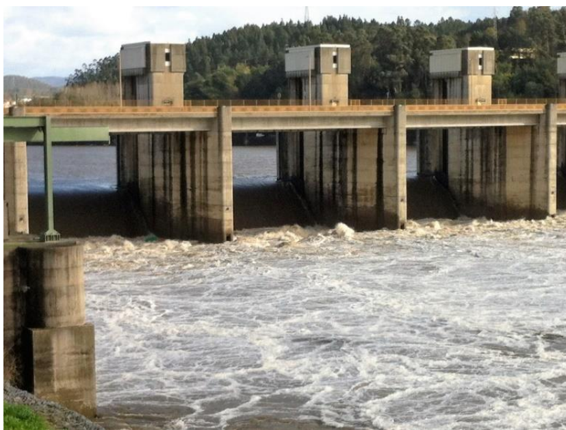
Fig. 9 – Pormenor das comportas numa situação de cheia intermédia. Cheia de 10 de Janeiro de 2016 (fotografia do autor)
