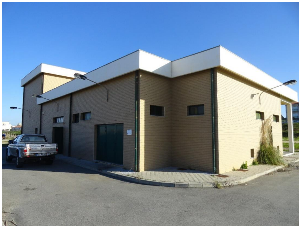
Figura 23 - Estação Elevatória "Molhe Sul"
