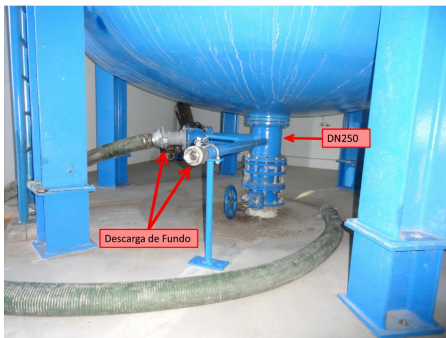
Figura 36 – Fotografia do Pormenor de Ligação ao RAC
