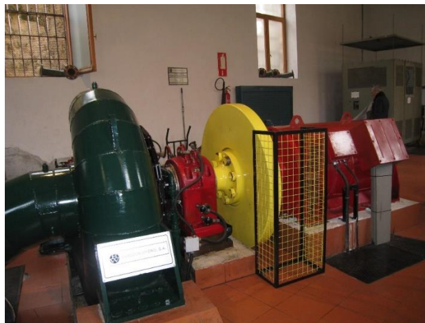
Figura 13 - Instalação com Volante de Inércia [1]
