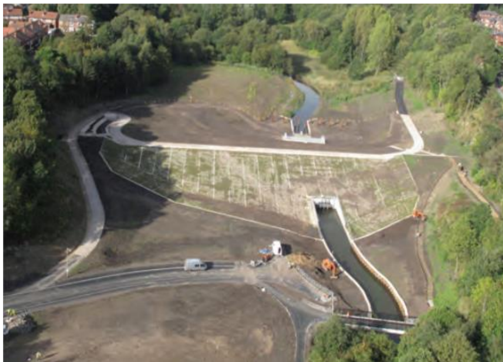
Fig.6.57 – Fotografia aérea de uma bacia de retenção aliada com dispositivo Hydro-Brake Flood Alleviation [31]
