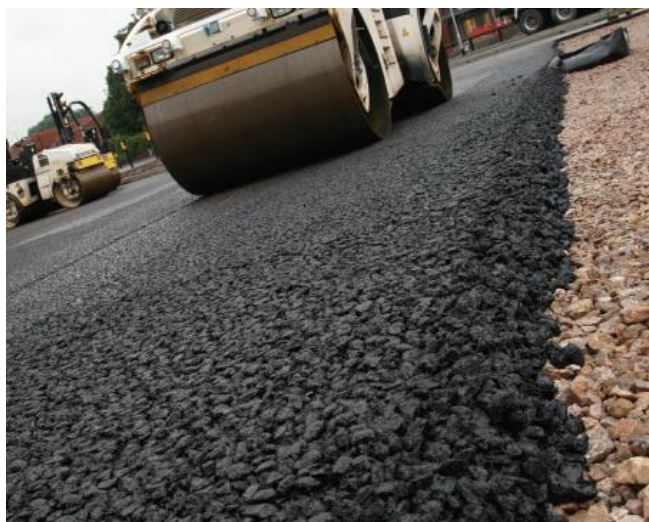
Fig.6.62 – Colocação do pavimento ULTISuDS [32]
