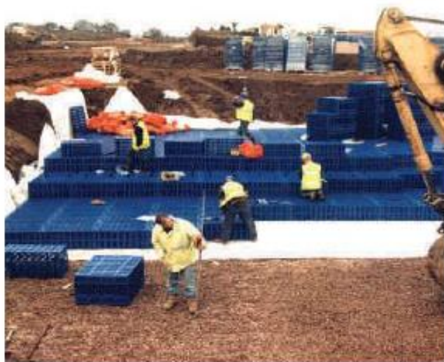
Fig.6.3 – Bacia de retenção, em fase de montagem, com módulos Aquacell [24]
