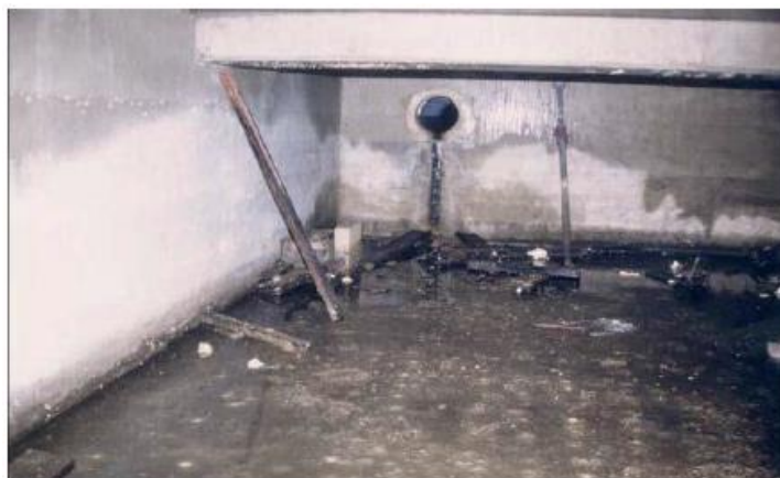
Fig.5.10 – Bacia de infiltração enterrada
