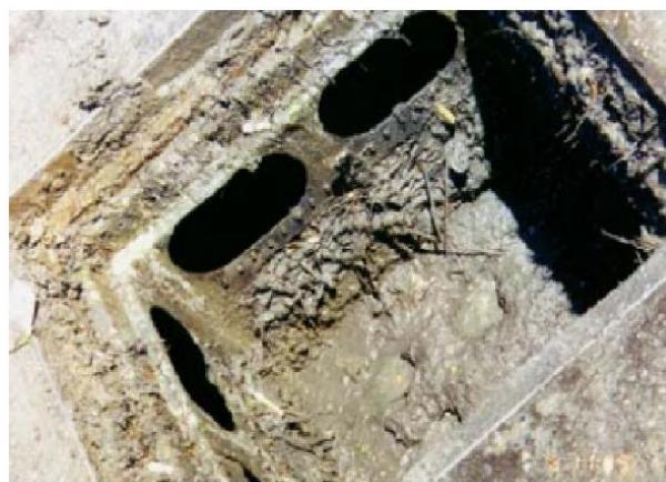
Fig.6.55 - Skimmer Box após retirada da peça superior [30]
