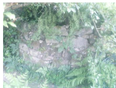
Fig. 165 – Socalco de pedra no terreno
