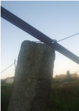
Fig. 153 – Esteio de pedra com perfil de ferro
