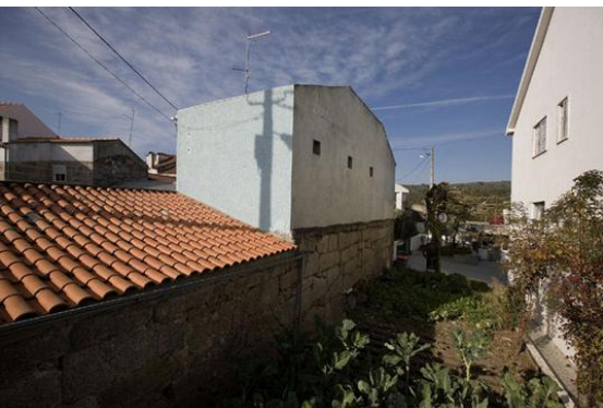
Fig. 19 – Edifício de habitação, Rapoula, Guarda, José Sócrates, 1986/87
