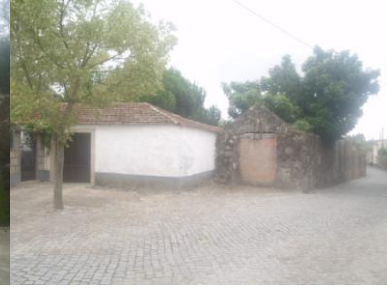
Fig. 141 – Casa pintada com umbreiras e muro em pedra.
