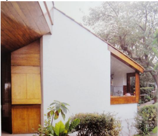
Fig. 179 – Acesso ao escritório com janela da cozinha em vista
