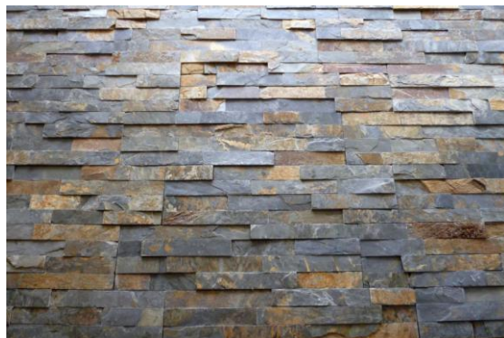
Fig. 315 – Alvenaria em xisto, tamanhos diferentes, corte regular, sem polimento.
