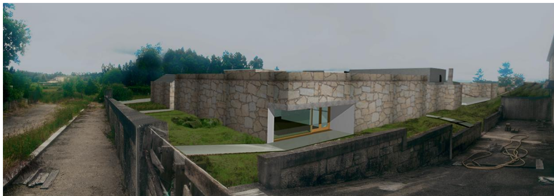
Fig. 319 – Três entradas entre os volumes da clínica e garagem vistos da Travessa Nova de Quiráz
