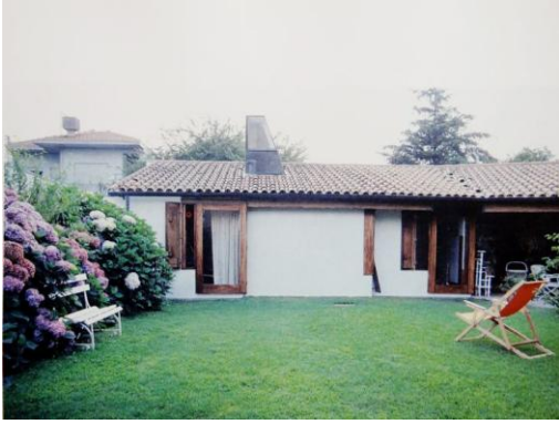
Fig. 175 – Exterior dos quartos
