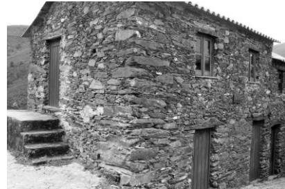
Fig. 10 – Casa em xisto, Aigra Nova (Centro Interior de Portugal)
