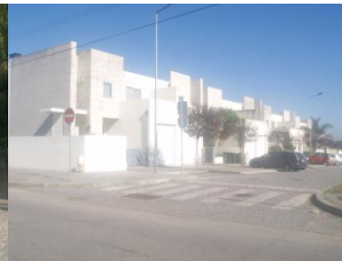
Fig. 103 – Habitações geminadas, Rua Nova de Quiráz
