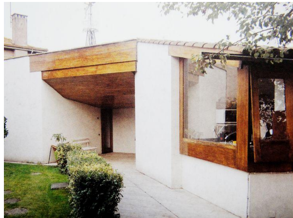
Fig. 180 – Acesso exterior ao escritório com janela da cozinha
