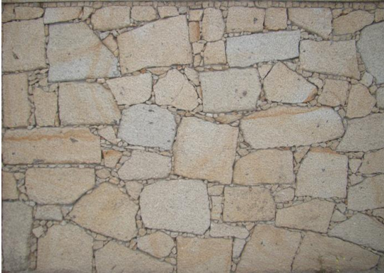
Fig. 310 – Alvenaria em granito, junta seca, diferentes tamanhos, corte irregular, sem polimento (Exemplo: Casa vernacular, Maia)
