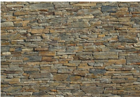
Fig. 314 – Alvenaria em xisto, tamanhos diferentes, corte irregular, sem polimento (Exemplo: Muros de terrenos, Alvarelhos, Maia)
