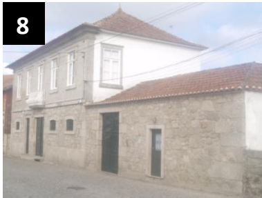
Fig. 126 – Casa em pedra e revestida a azulejo
