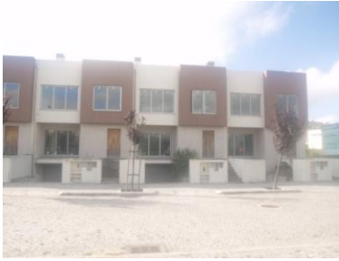
Fig. 92 – Habitações geminadas desabitadas, Rua Central do Paço
