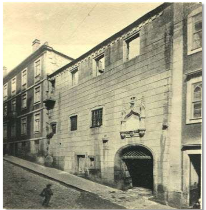
Fachada principal da Casa do Infante, c.1920. A. de Carvalho Cerqueira, Araújo & Sobrinho.
