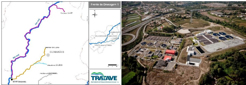
Figura 15- 1ª Frente de drenagem
