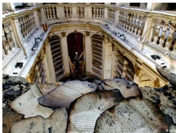
Fig. 1.2 – Após o incêndio, o panorama da biblioteca Anna Amalia (AK., 2007).
