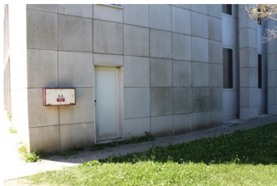
Fig. 4.4 – Saída de emergência lateral do piso -1, pela qual seguiu um dos grupos evacuados.
