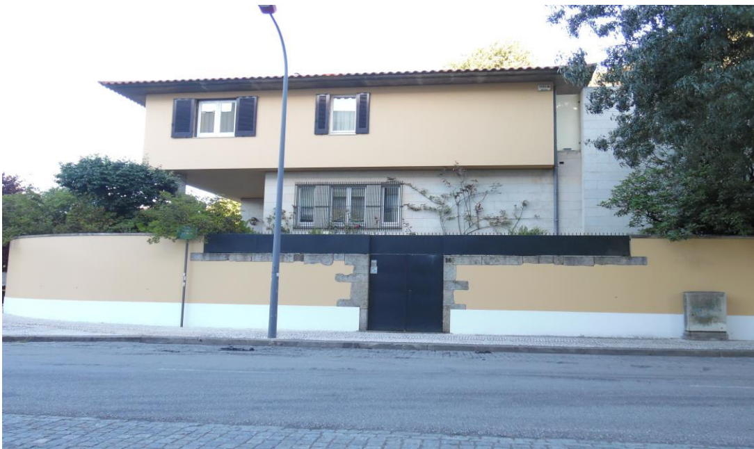
Figura 17 - Exemplo de uma vedação constituída por um muro de tijolo caiado, chapas e vegetação com cerca de 2,5 metros na rua António Cardoso. Foto de Andreia Fernandes.
