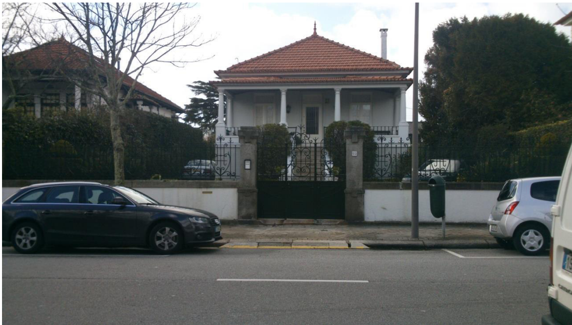
Figura 12 - Exemplo de uma casa com características tradicionais no bairro Guerra Junqueiro projetada por Aucíndio Ferreira dos Santos e Carlos Nogueira Pontes. Moradia 93, rua Guerra Junqueiro, proprietário António Joaquim Ferreira - A.H.C.M.P. Processo de obras, 6 de Outubro de 1929, D-CMP/9(567), f. 343-353. Fotografia de Andreia Fernandes.
