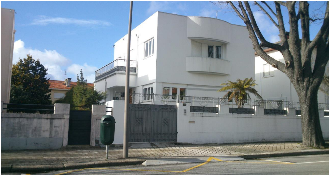
Figura 16 - Exemplo de uma vedação constituída por um muro de tijolo caiado, chapas e gradeamento. Foto de Andreia Fernandes.
