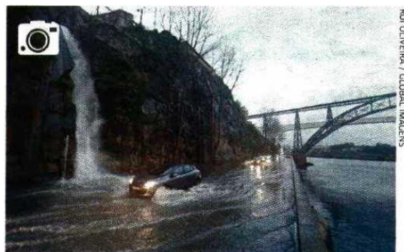
PORTO ÁGUA A CAIR NA ESCARPA AFETA TRÂNSITO A situação não é inédita, mas assusta e bem quem circula na Avenida de Gustavo Eiffel, junto à escarpa dos Guindais, em momentos de muita chuva, como ao fim da tarde de ontem.
