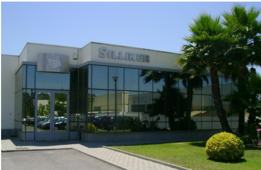
Figura 1 - Instalações da Silliker Portugal SA. [7] .
