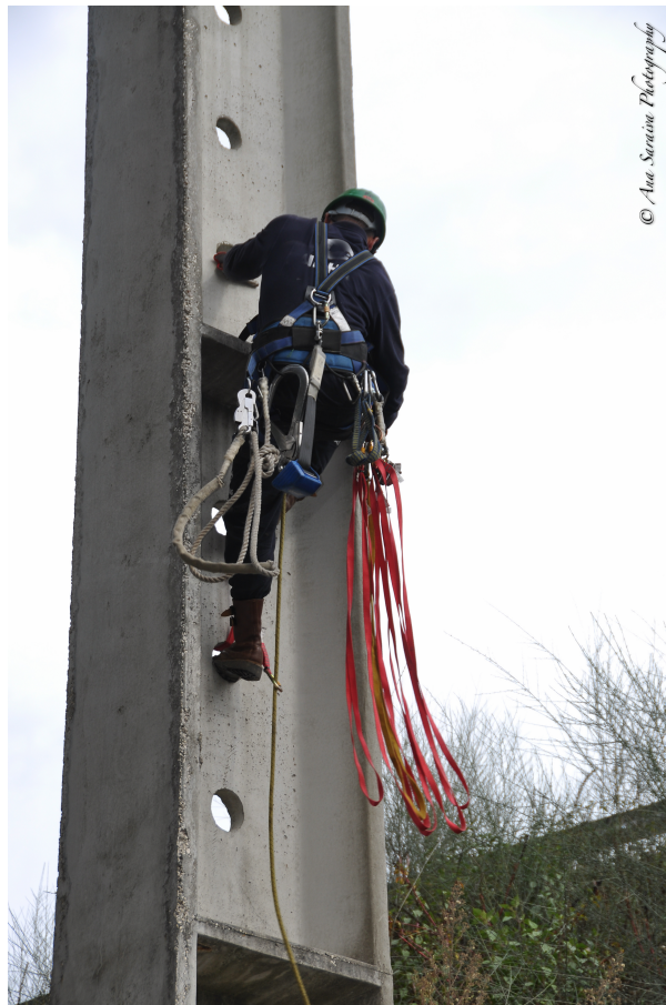
Figura 12.2: Desajuste ergonômico dos orifícios do poste às dimensões do executante
