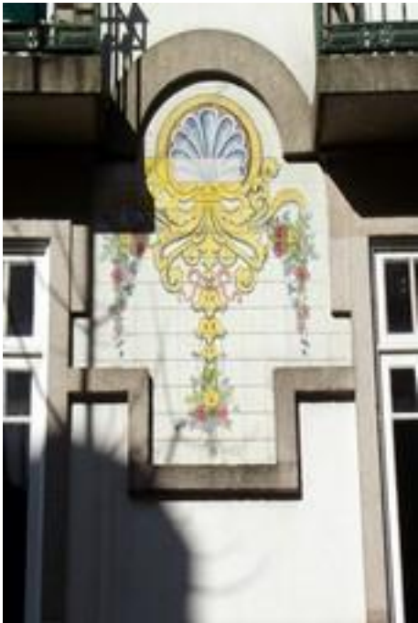
Figura 2245: Pormenor do Revestimento da Casa nº 129.
