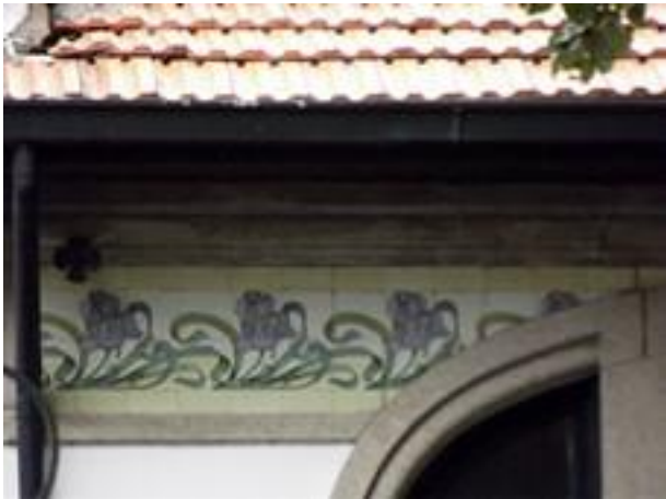
Figura 2840: Pormenor do Revestimento da Casa nº 234
