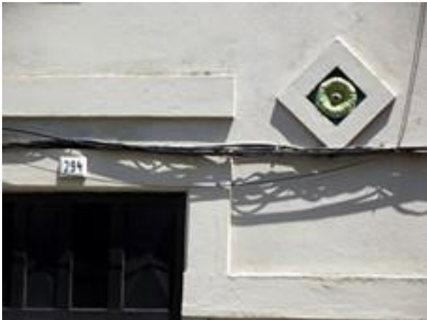
Figura 2905: Pormenor do Revestimento da Casa nº 294-296.
