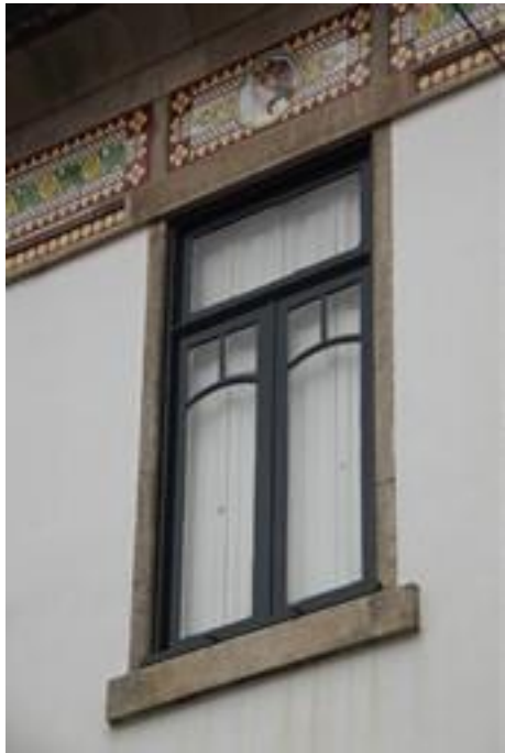
Figura 2354: Pormenor do e Revestimento da Casa nº 1035.
