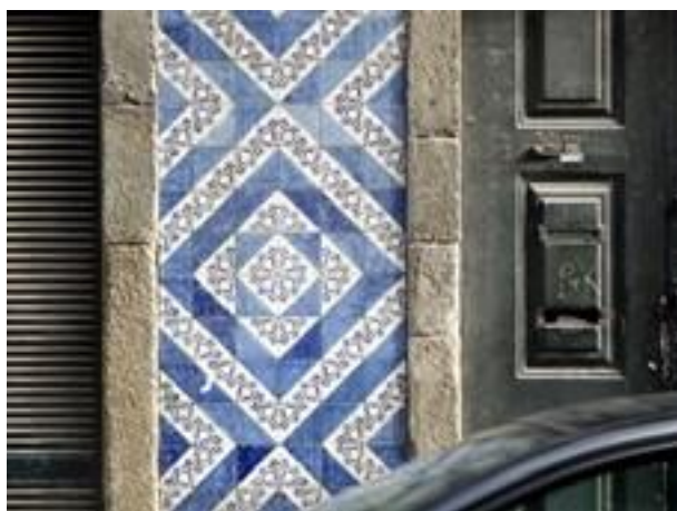
Figura 2855: Revestimento da Casa nº 1-11.
