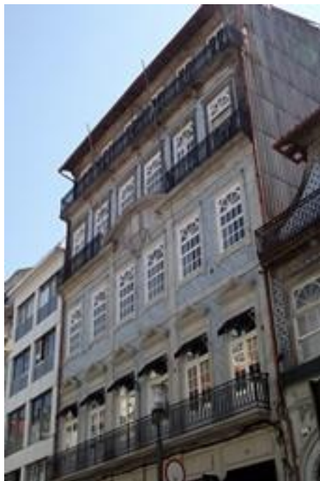
Figura 2699: Vista Geral do Edifício das Obras Públicas.
