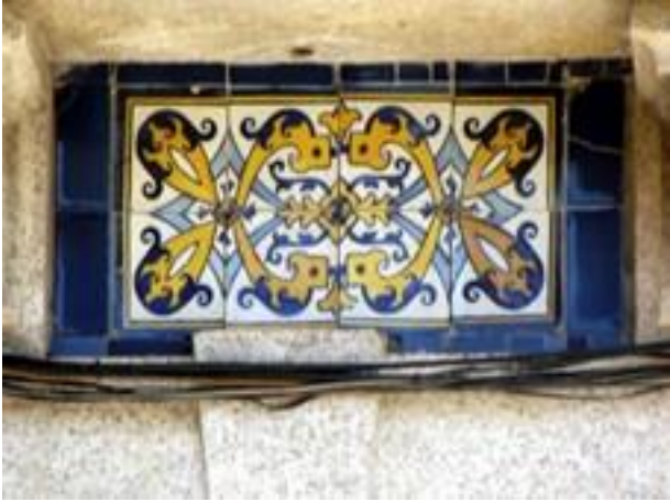
Figura 2849: Pormenor do Revestimento da Casa nº 155-157.
