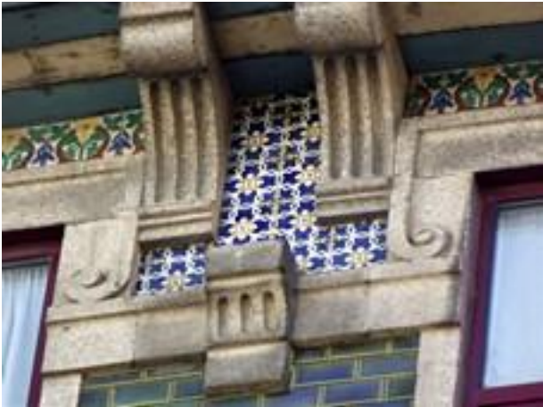
Figura 2797: Pormenor do Revestimento da Casa nº 308.
