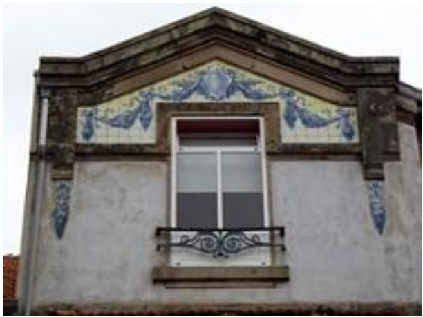
Figura 2341: Pormenor do e Revestimento da Casa nº 1026.
