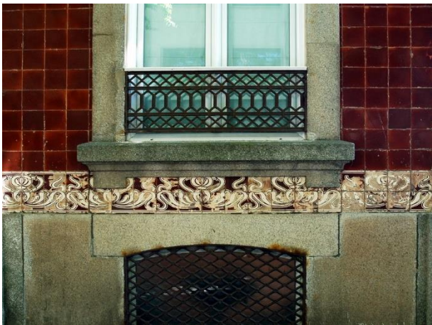
Figura 2890: Pormenor do Revestimento da Casa nº 200.
