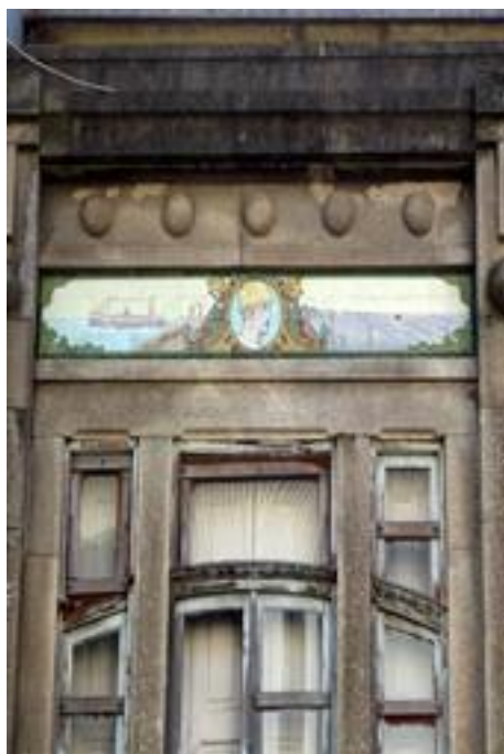
Figura 2488: Pormenor do Revestimento da Casa nº 144.
