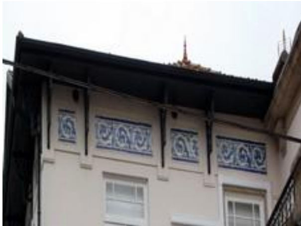
Figura 2321: Pormenor do Revestimento da Casa nº 799.
