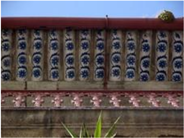
Figura 2296: Pormenor das Telhas da Casa nº 34.
