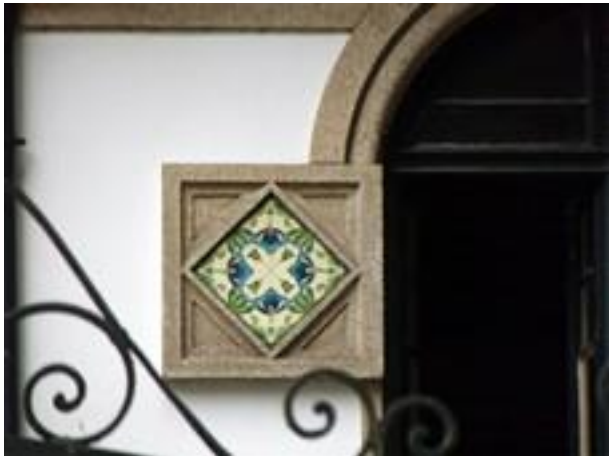
Figura 2839: Pormenor do Revestimento da Casa nº 234.
