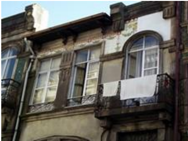
Figura 2799: Pormenor do Revestimento da Casa nº 310.
