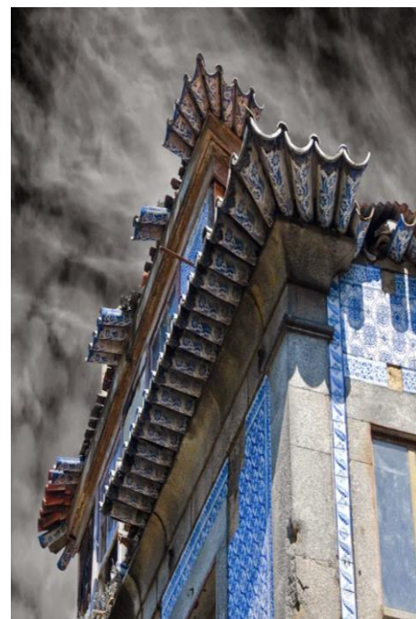
Figura 3086: Pormenor do edifício da FSAVP.
