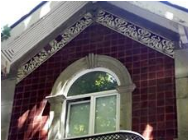
Figura 2888: Pormenor do Revestimento da Casa nº 200.
