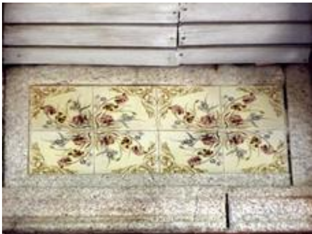
Figura 2883: Pormenor do Revestimento da Casa nº 22.
