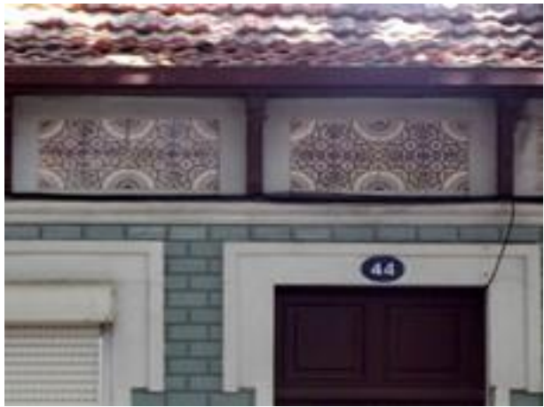
Figura 2884: Pormenor do Revestimento da Casa nº 44-54.
