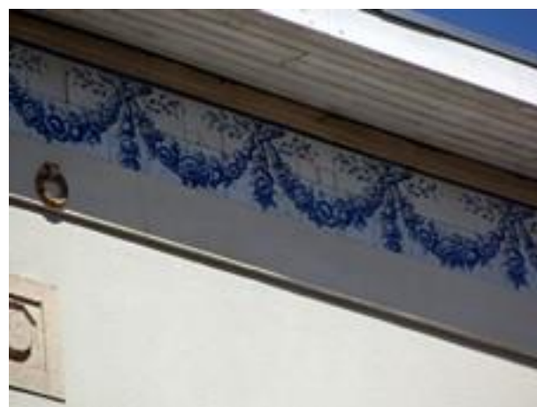
Figura 2852: Pormenor do Revestimento da Casa nº 187.
