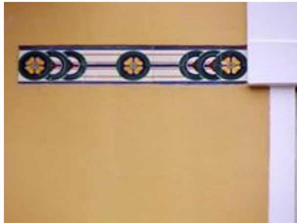
Figura 2481: Pormenor do Revestimento da Casa nº 35-41.
