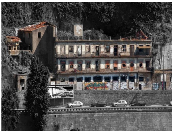
Figura 3080: Estado Atual da Fábrica do Carvalhinho.
