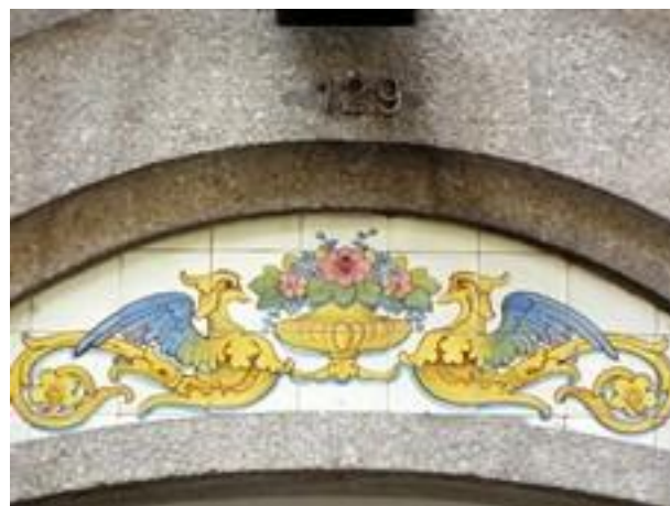
Figura 2249: Pormenor do Revestimento da Casa nº 129.
