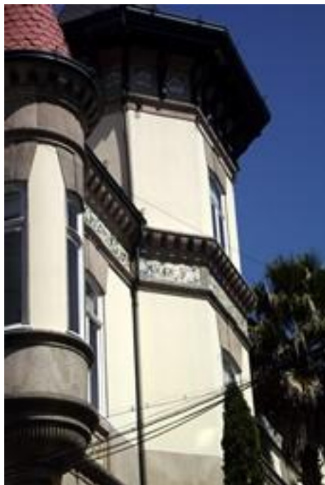
Figura 2694: Pormenor do Revestimento da Casa nº 1316.
