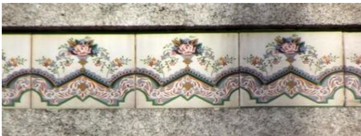
Figura 2501: Pormenor do Revestimento da Casa nº 156.
