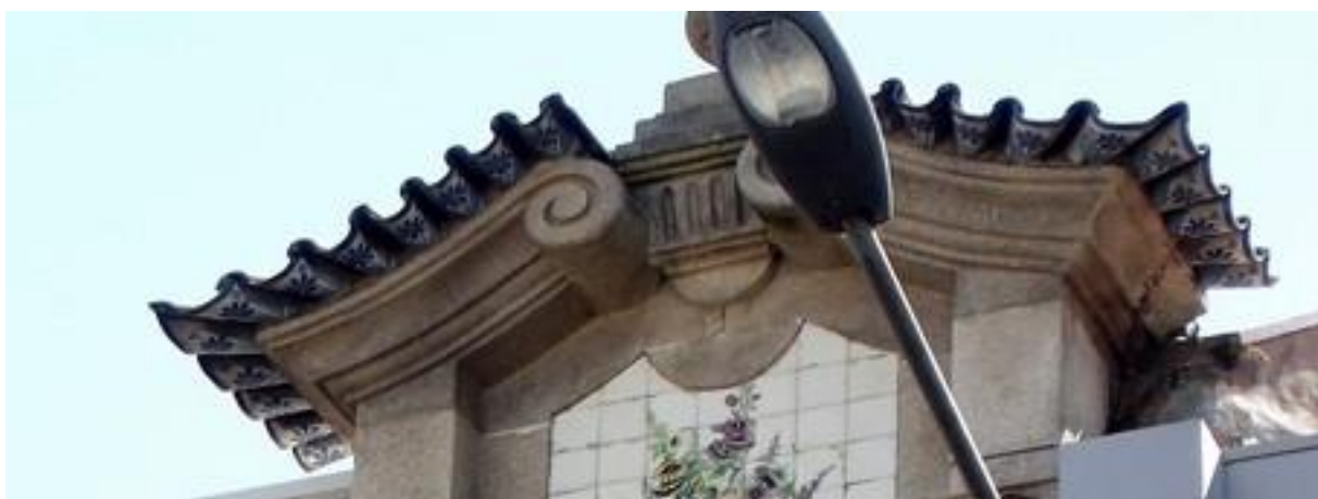
Figura 2398: Telhas da Casa nº 982.
