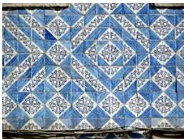
Figura 2856: Revestimento da Casa nº 1-11.
