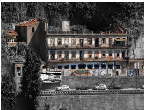
Figura 3078: Estado Atual da Fábrica do Carvalhinho.
