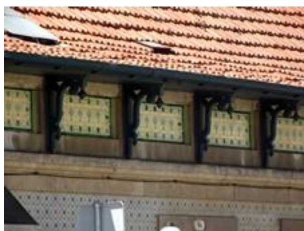
Figura 2431: Painéis de Azulejo Relevado da Casa nº 83.
