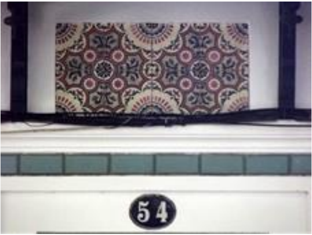
Figura 2885: Pormenor do Revestimento da Casa nº 44-54.
