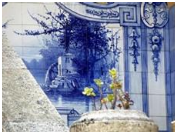
Figura 2547: Pormenor do Revestimento da Casa nº 349.
