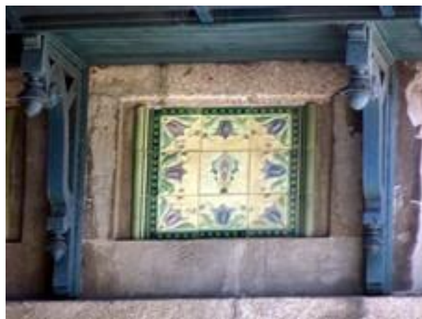
Figura 2434: Painéis de Azulejo Relevado da Casa nº 83.
