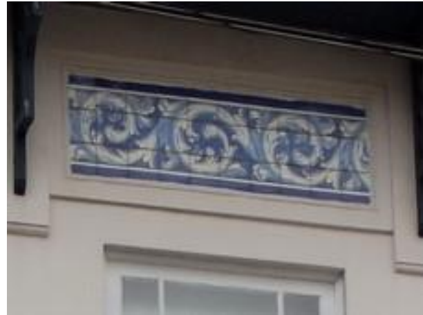
Figura 2322: Pormenor do Revestimento da Casa nº 799.
