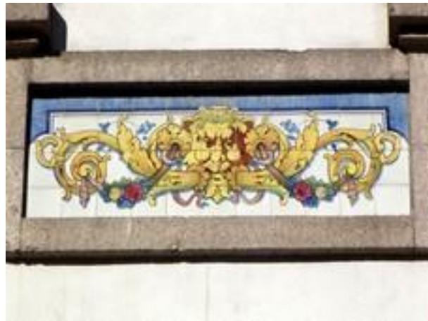
Figura 2247: Pormenor do Revestimento da Casa nº 129.
