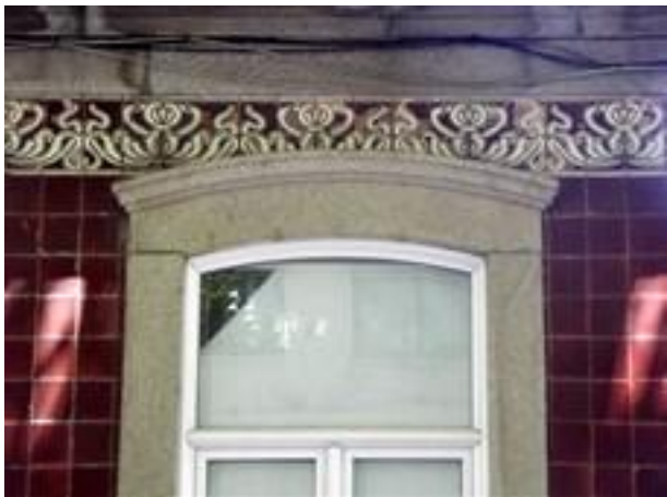
Figura 2889: Pormenor do Revestimento da Casa nº 200.
