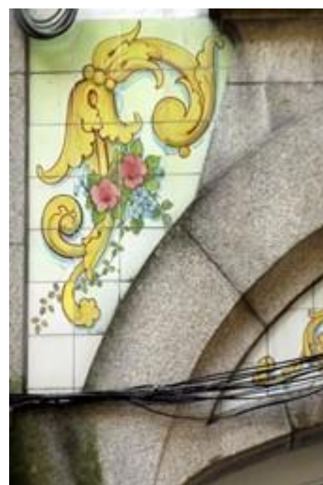
Figura 2253: Pormenor do Revestimento da Casa nº 129.
