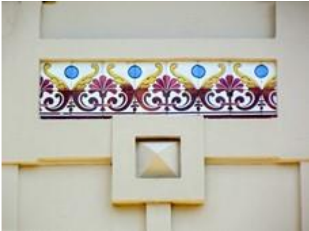
Figura 2906: Pormenor do Revestimento da Casa nº 294-296.
