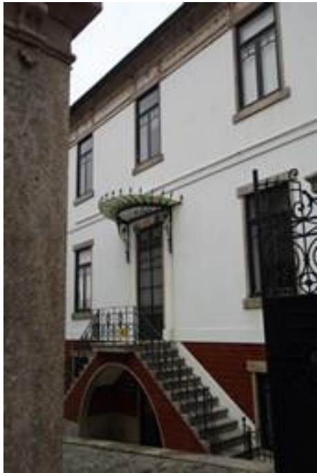
Figura 2353: Pormenor do e Revestimento da Casa nº 1035.
