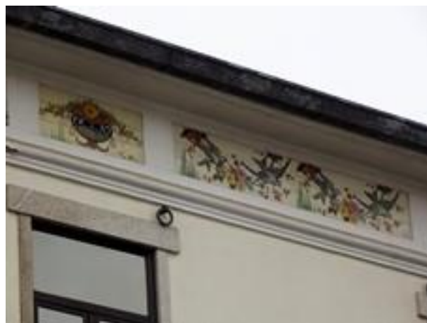
Figura 2346: Pormenor do e Revestimento da Casa nº 1026.
