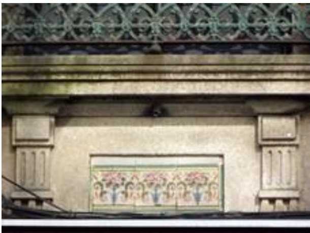
Figura 2498: Pormenor do Revestimento da Casa nº 156.
