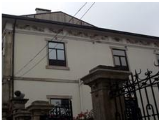
Figura 2345: Pormenor do e Revestimento da Casa nº 1026.
