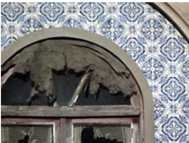
Figura 2589: Pormenor do Revestimento da Casa nº 620.
