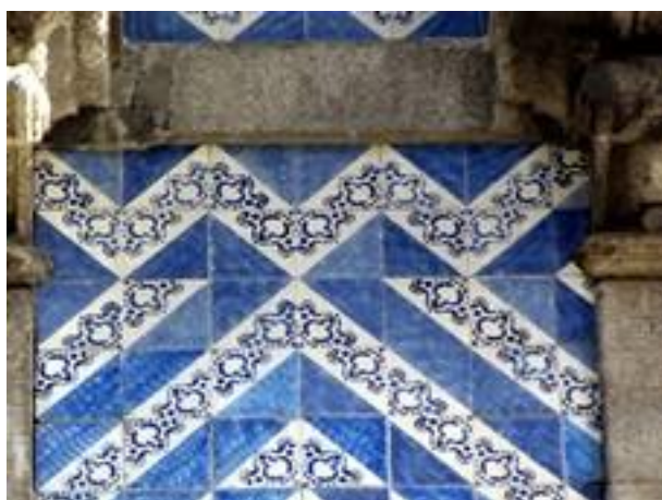
Figura 2857: Revestimento da Casa nº 1-11.
