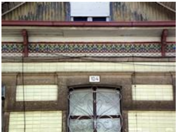
Figura 2845: Pormenor do Revestimento da Casa nº 104.
