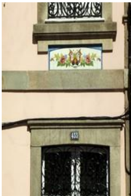
Figura 2452: Pormenor do Revestimento da Casa nº 455
