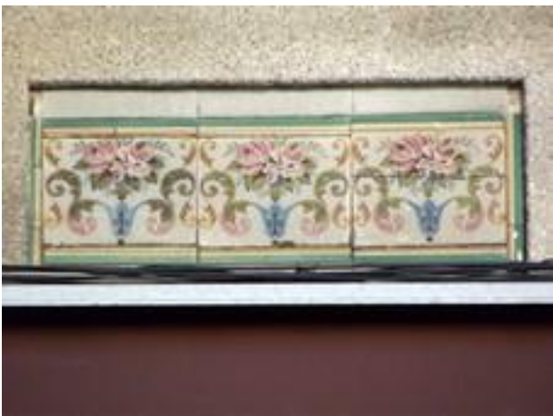
Figura 2499: Pormenor do Revestimento da Casa nº 156.
