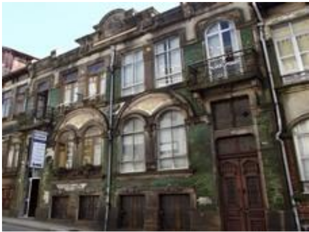
Figura 2803: Pormenor do Revestimento da Casa nº 314.
