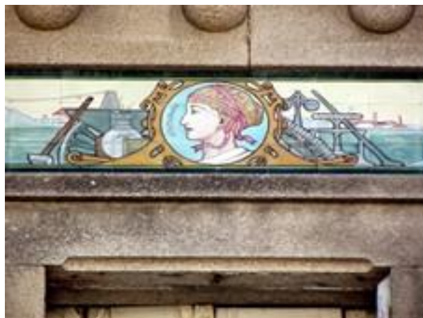
Figura 2493: Pormenor do Revestimento da Casa nº 144.
