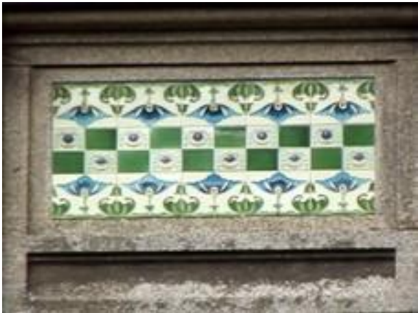
Figura 2837: Pormenor do Revestimento da Casa nº 234.
