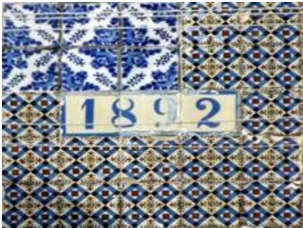
Figura 2299: Pormenor do Revestimento da Casa nº 50.
