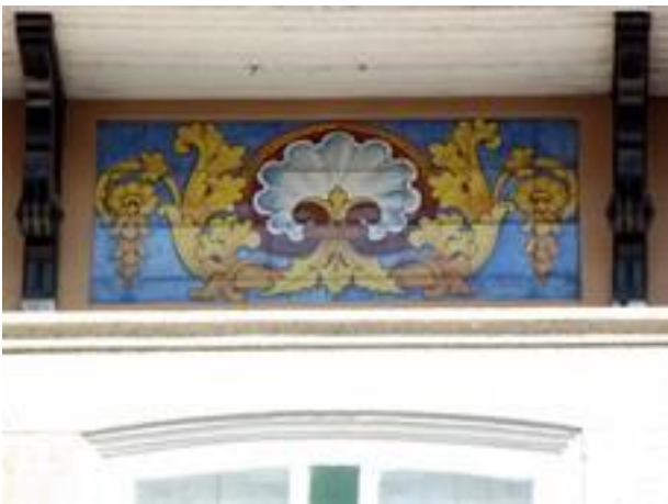
Figura 2450: Pormenor do Revestimento da Casa nº 455
