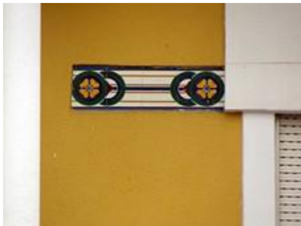
Figura 2480: Pormenor do Revestimento da Casa nº 35-41.
