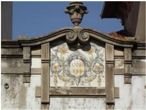
Figura 2588: Pormenor do Revestimento da Casa nº 620.
