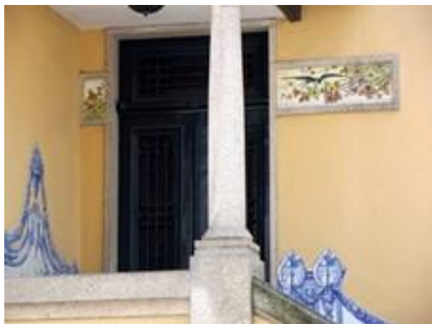
Figura 2544: Pormenor do Revestimento da Casa nº 349.
