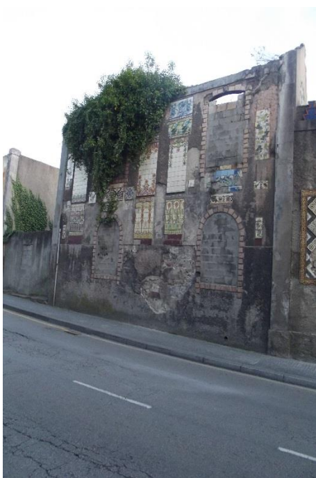
Figura 3081: Estado Atual da Fábrica das Devesas.
