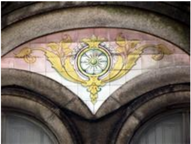
Figura 2805: Pormenor do Revestimento da Casa nº 314.
