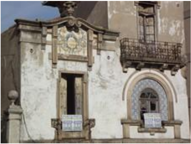
Figura 2587: Pormenor do Revestimento da Casa nº 620.
