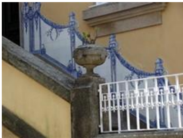
Figura 2548: Pormenor do Revestimento da Casa nº 349.
