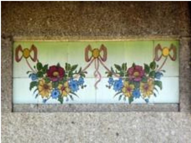
Figura 2850: Pormenor do Revestimento da Casa nº 161.
