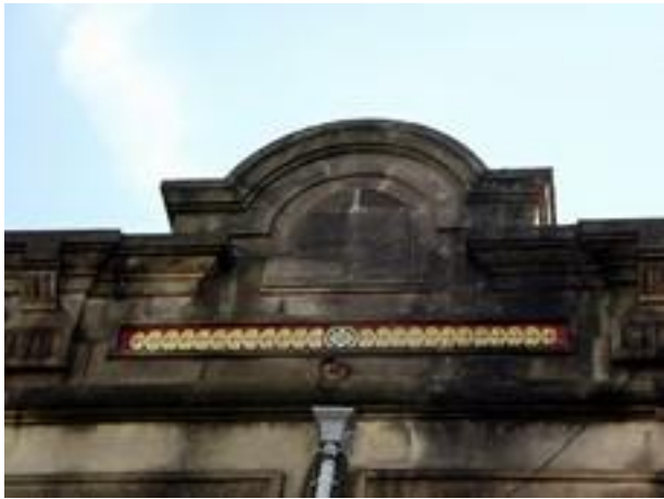
Figura 2806: Pormenor do Revestimento da Casa nº 314.
