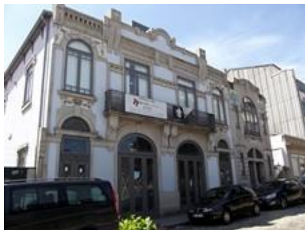
Figura 2203: Vista Geral das Casas nº 373-389.
