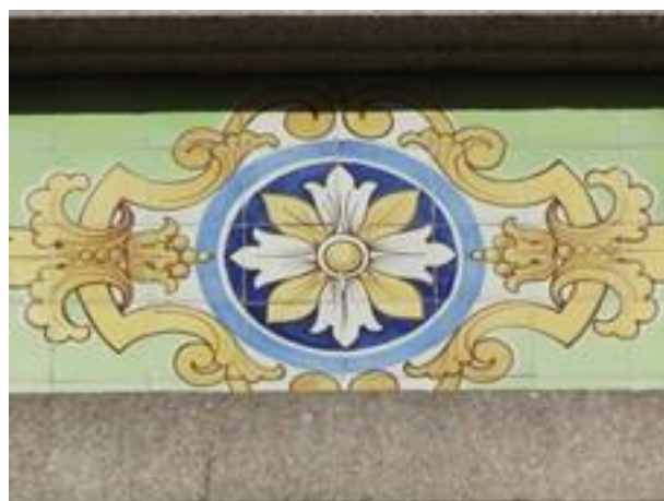
Figura 2248: Pormenor do Revestimento da Casa nº 129.
