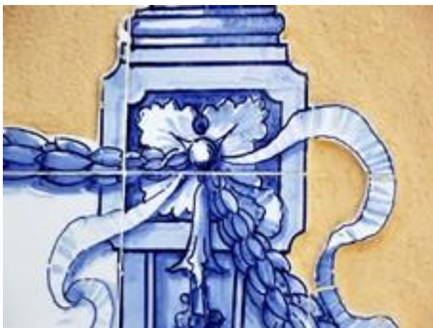
Figura 2551: Pormenor do Revestimento da Casa nº 349.
