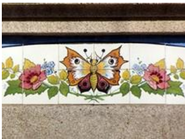
Figura 2454: Pormenor do Revestimento da Casa nº 455
