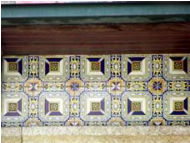
Figura 2914: Pormenor do Revestimento da Casa nº 339.
