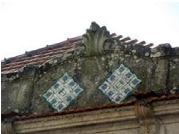
Figura 2628: Pormenor do Revestimento das Casas nº 1143-1153.
