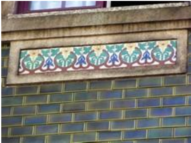
Figura 2798: Pormenor do Revestimento da Casa nº 308.
