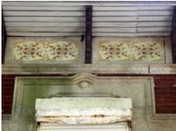
Figura 2882: Pormenor do Revestimento da Casa nº 22.
