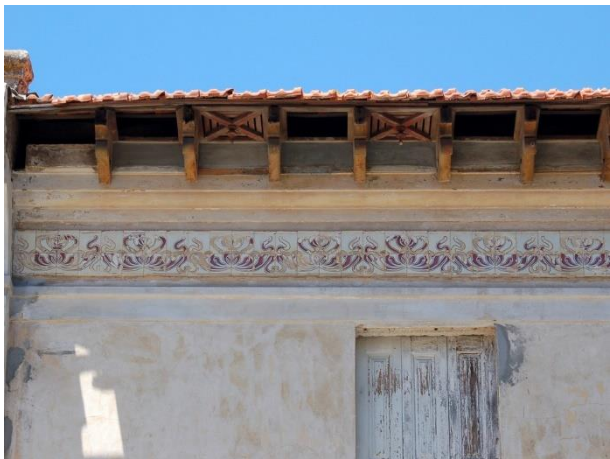
Figura 2981: Pormenor do Friso de Revestimento da Casa nº 134.
