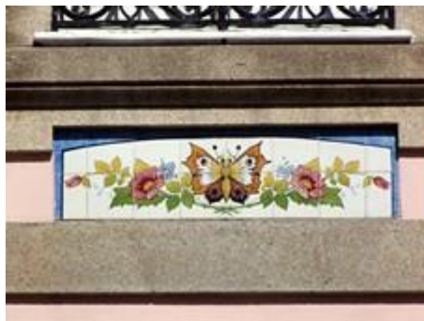
Figura 2453: Pormenor do Revestimento da Casa nº 455
