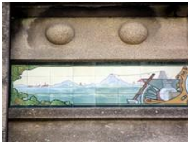
Figura 2494: Pormenor do Revestimento da Casa nº 144.
