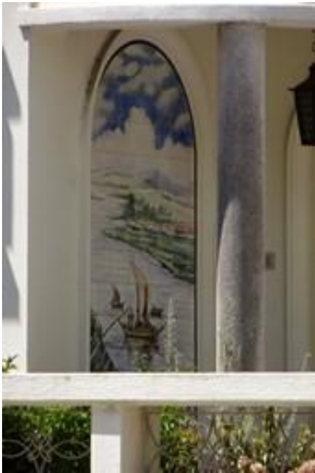
Figura 2722: Localização do Painel Figurativo da Casa nº 1353.
