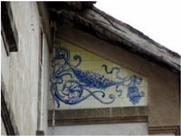
Figura 2342: Pormenor do e Revestimento da Casa nº 1026.
