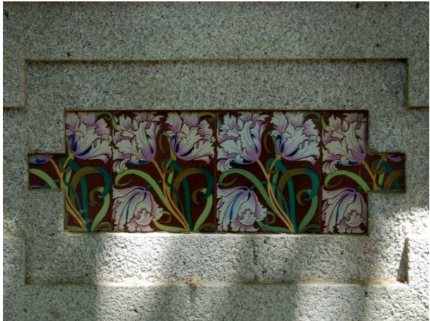
Figura 2880: Pormenor do Revestimento da Casa nº 22.
