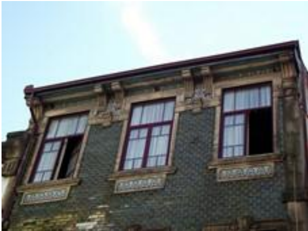
Figura 2796: Pormenor do Revestimento da Casa nº 308.
