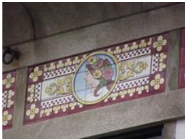
Figura 2356: Pormenor do e Revestimento da Casa nº 1035.
