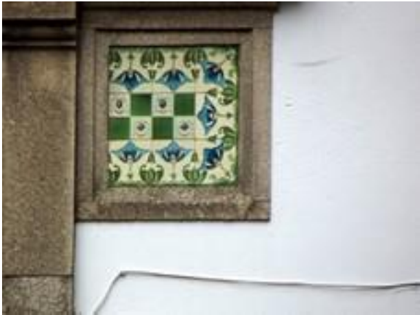
Figura 2838: Pormenor do Revestimento da Casa nº 234.
