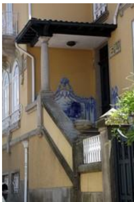
Figura 2546: Pormenor do Revestimento da Casa nº 349.
