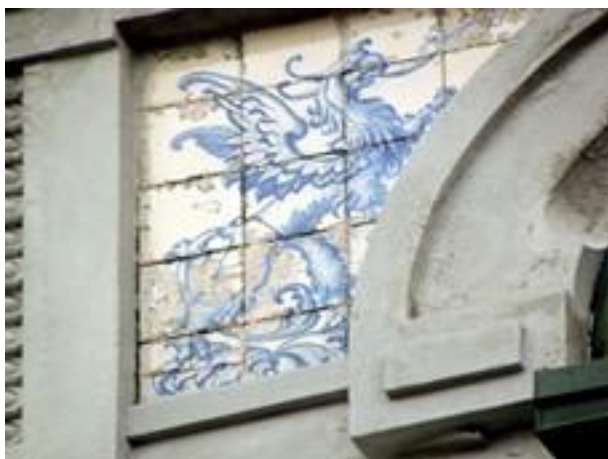
Figura 3075: Pormenor de um Painel Figurativo da Casa nº 13.
