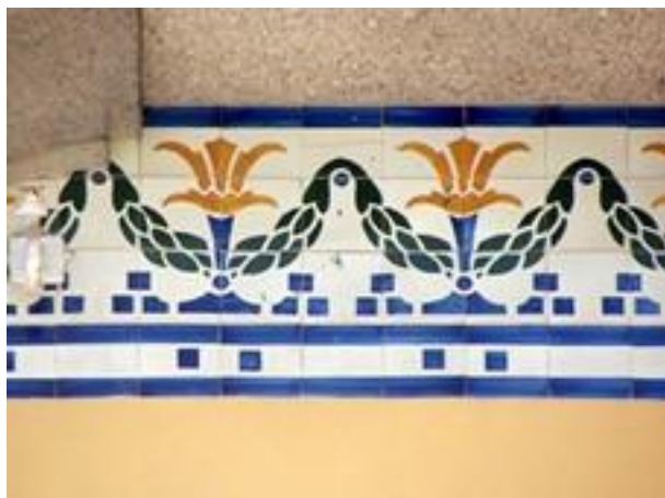
Figura 2540: Pormenor do Revestimento da Casa nº 349.
