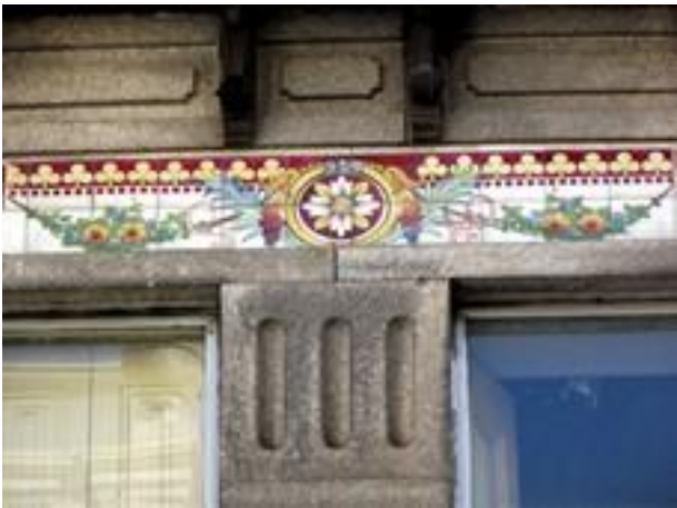
Figura 2800: Pormenor do Revestimento da Casa nº 310.
