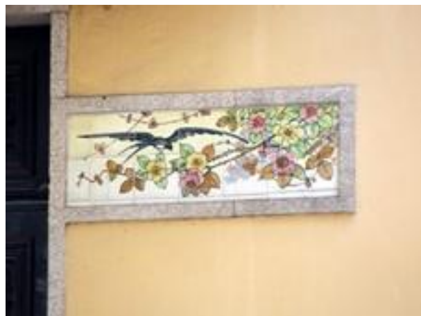
Figura 2545: Pormenor do Revestimento da Casa nº 349.
