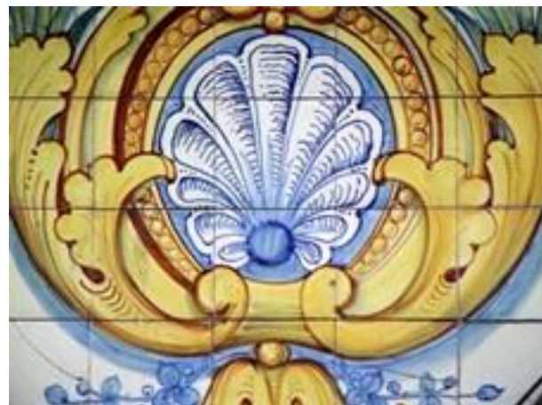
Figura 2251: Pormenor do Revestimento da Casa nº 129.
