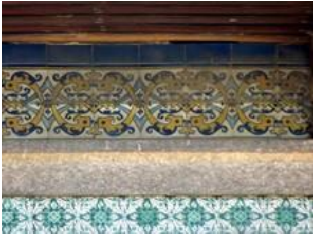
Figura 2908: Pormenor do Revestimento da Casa nº 318.
