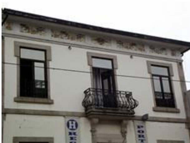
Figura 2349: Pormenor do e Revestimento da Casa nº 1027.
