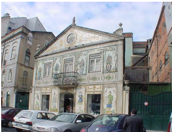
Figura 3087: Estado Atual da Fábrica de Cerâmica Viúva Lamego.
