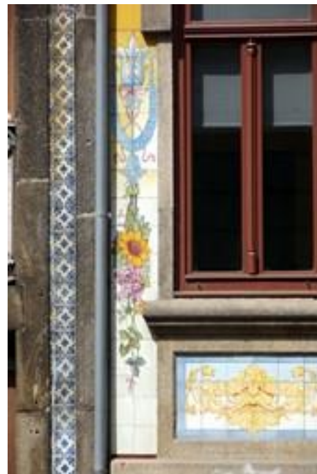
Figura 2408: Pormenor do Revestimento da Casa nº 160.
