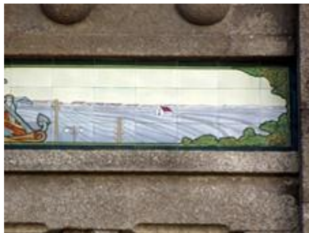
Figura 2491: Pormenor do Revestimento da Casa nº 144.
