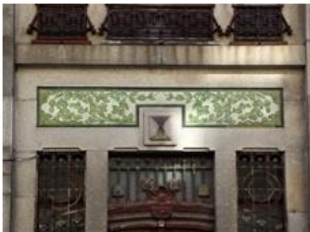
Figura 2486: Pormenor do Revestimento da Casa nº 144.
