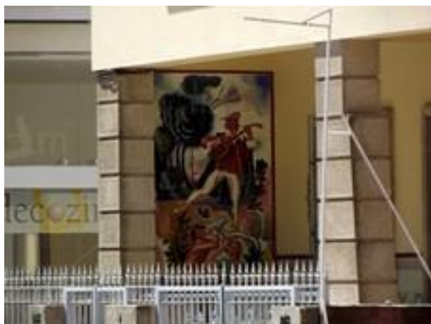
Figura 2720: Localização do Painel Figurativo da Casa nº 1215.
