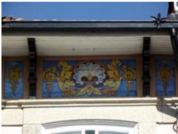
Figura 2449: Pormenor do Revestimento da Casa nº 455
