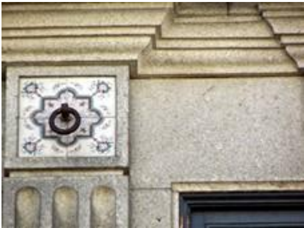
Figura 2497: Pormenor do Revestimento da Casa nº 156.
