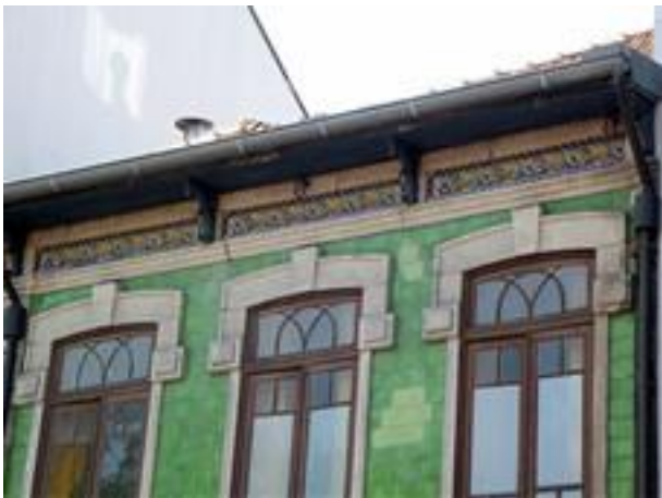
Figura 2911: Pormenor do Revestimento da Casa nº 339.
