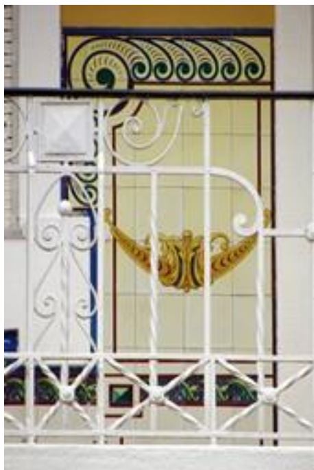
Figura 2482: Pormenor do Revestimento da Casa nº 35-41.
