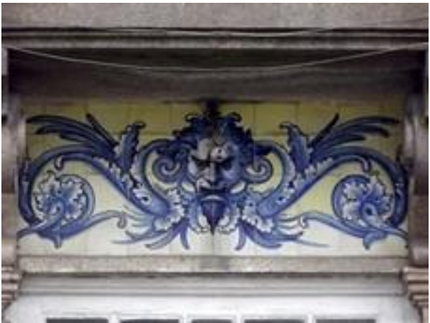
Figura 2344: Pormenor do e Revestimento da Casa nº 1026.
