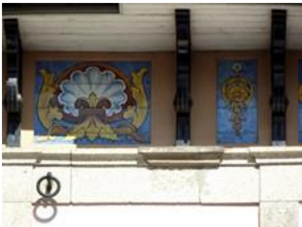
Figura 2451: Pormenor do Revestimento da Casa nº 455
