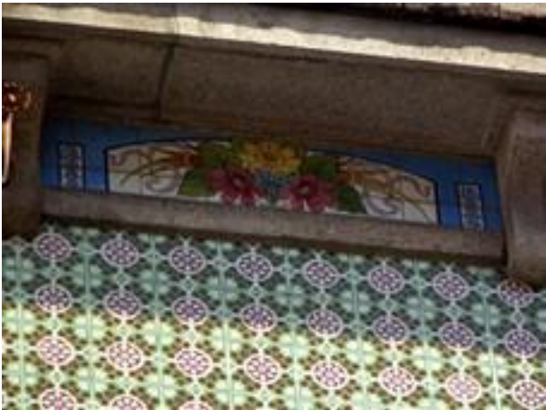
Figura 2574: Pormenor do Revestimento da Casa nº 321.
