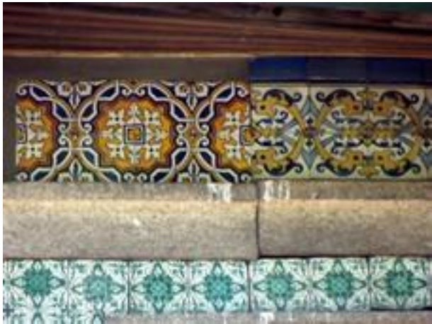
Figura 2907: Pormenor do Revestimento da Casa nº 318.
