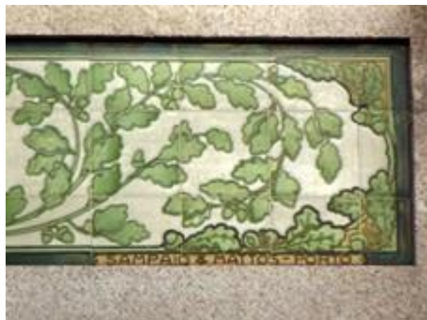
Figura 2487: Pormenor do Revestimento da Casa nº 144.
