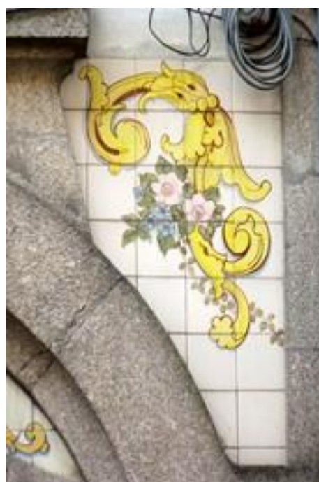
Figura 2252: Pormenor do Revestimento da Casa nº 129.
