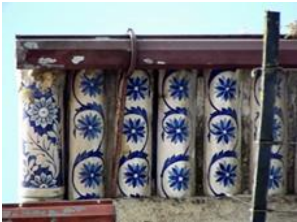
Figura 2297: Pormenor das Telhas da Casa nº 34.
