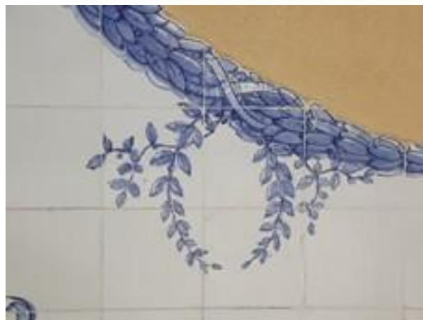
Figura 2549: Pormenor do Revestimento da Casa nº 349.
