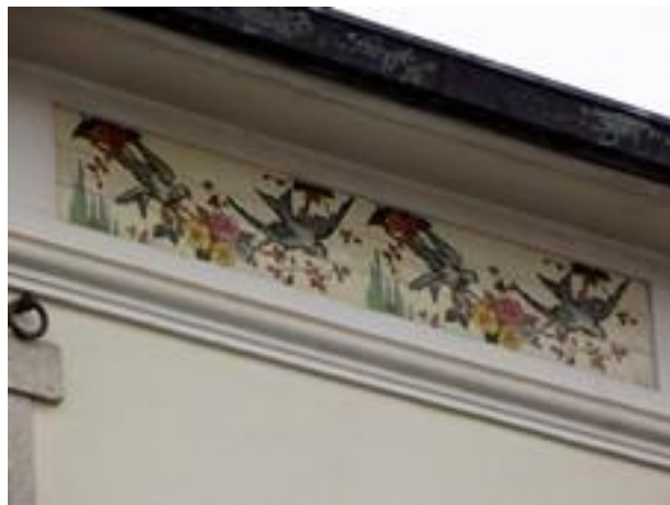
Figura 2348: Pormenor do e Revestimento da Casa nº 1026.
