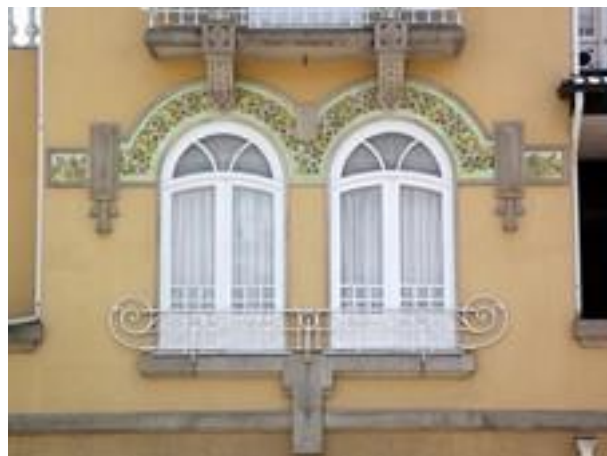
Figura 2541: Pormenor do Revestimento da Casa nº 349.
