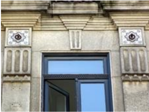
Figura 2496: Pormenor do Revestimento da Casa nº 156.
