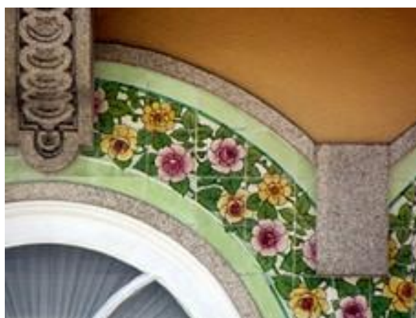
Figura 2543: Pormenor do Revestimento da Casa nº 349.
