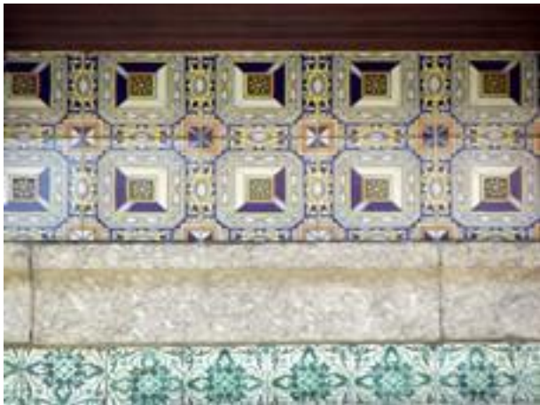
Figura 2913: Pormenor do Revestimento da Casa nº 339.
