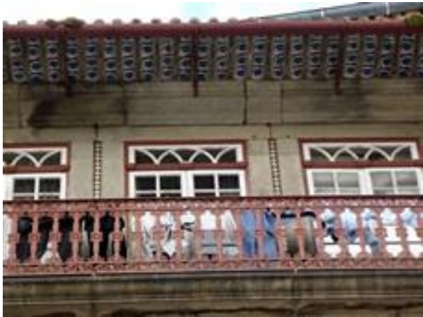
Figura 2295: Telhas da Casa nº 34.
