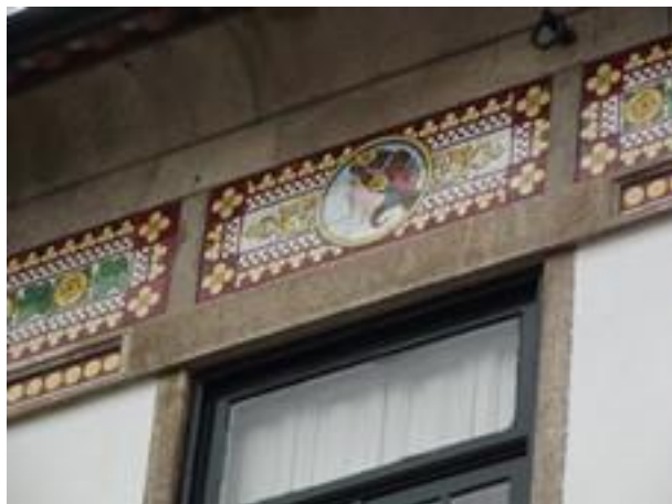
Figura 2355: Pormenor do e Revestimento da Casa nº 1035.
