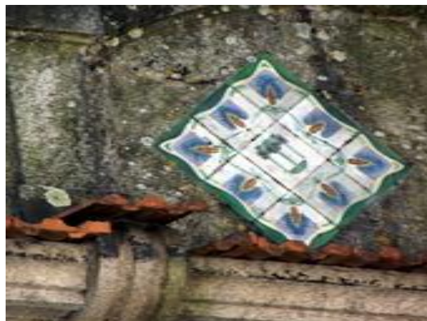
Figura 2629: Pormenor do Revestimento das Casas nº 1143-1153.
