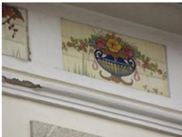
Figura 2347: Pormenor do e Revestimento da Casa nº 1026.
