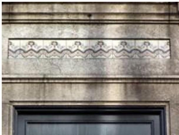
Figura 2500: Pormenor do Revestimento da Casa nº 156.
