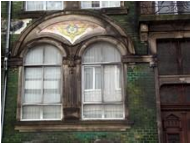
Figura 2804: Pormenor do Revestimento da Casa nº 314.
