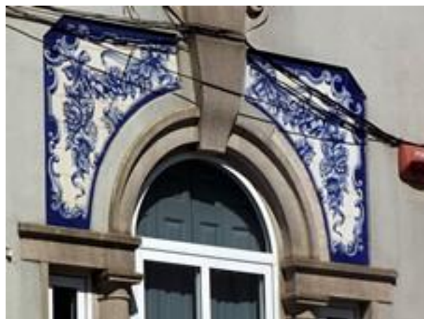
Figura 2852: Pormenor do Revestimento da Casa nº 161.
