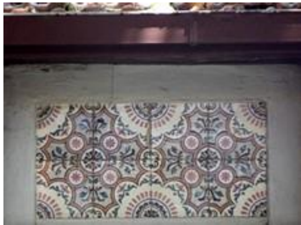
Figura 2886: Pormenor do Revestimento da Casa nº 44-54.
