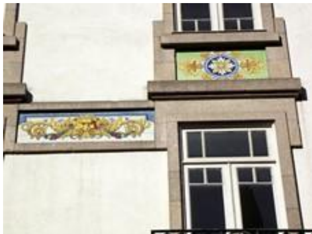
Figura 2246: Pormenor do Revestimento da Casa nº 129.
