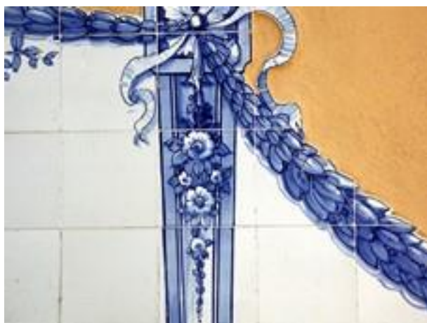
Figura 2550: Pormenor do Revestimento da Casa nº 349.
