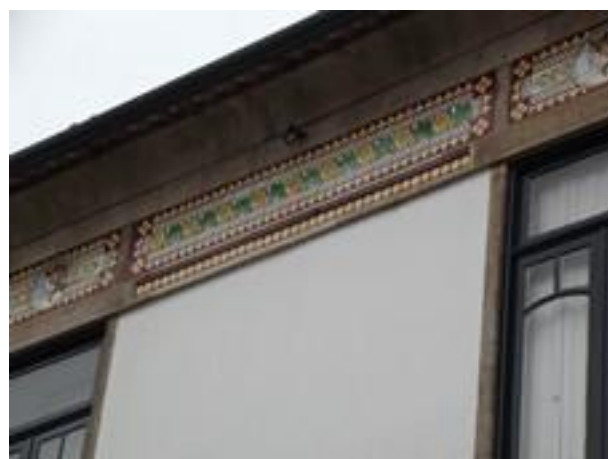
Figura 2357: Pormenor do e Revestimento da Casa nº 1035.
