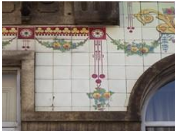
Figura 2801: Pormenor do Revestimento da Casa nº 310.
