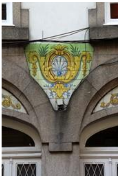
Figura 2250: Pormenor do Revestimento da Casa nº 129.
