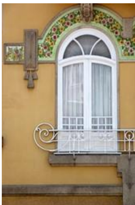
Figura 2542: Pormenor do Revestimento da Casa nº 349.
