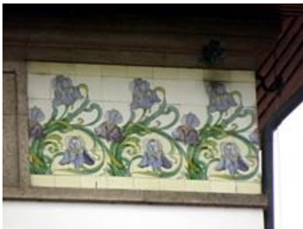
Figura 2841: Pormenor do Revestimento da Casa nº 234.
