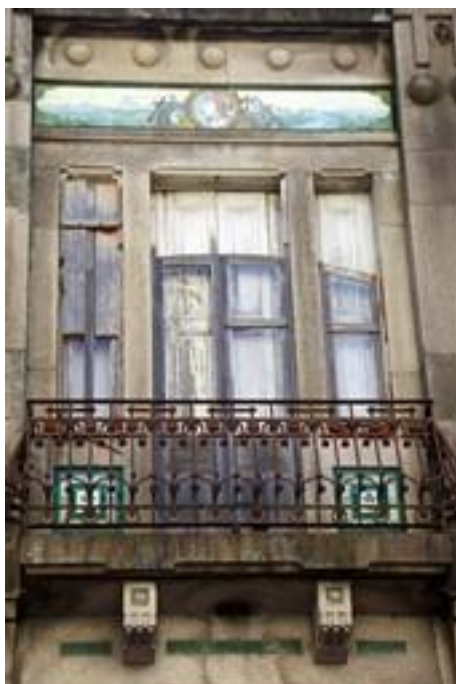
Figura 2492: Pormenor do Revestimento da Casa nº 144.
