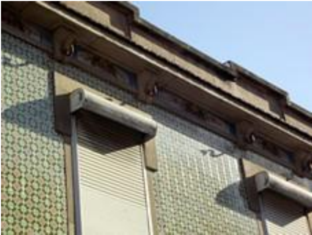
Figura 2573: Pormenor do Revestimento da Casa nº 321.
