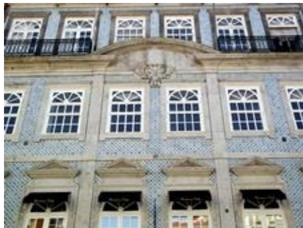
Figura 2700: Pormenor do Revestimento do Edifício das Obras Públicas.
