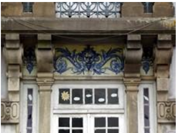
Figura 2343: Pormenor do e Revestimento da Casa nº 1026.
