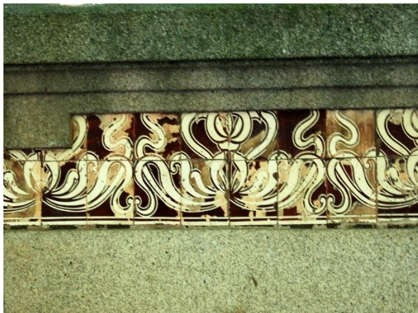
Figura 2891: Pormenor do Revestimento da Casa nº 200.
