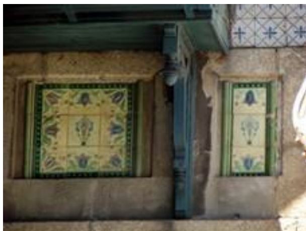
Figura 2433: Painéis de Azulejo Relevado da Casa nº 83.
