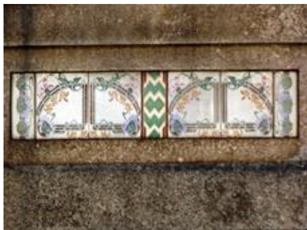
Figura 2847: Pormenor do Revestimento da Casa nº 104.
