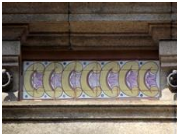
Figura 2407: Pormenor do Revestimento da Casa nº 160.
