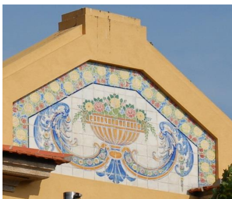
Figura 55: Casa com frontão na Avenida de França (nº 549), Porto. ©
