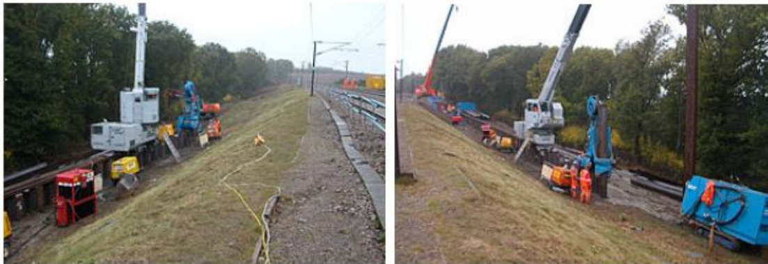
Fig. 2.29 – Aspeto geral da obra [9]
