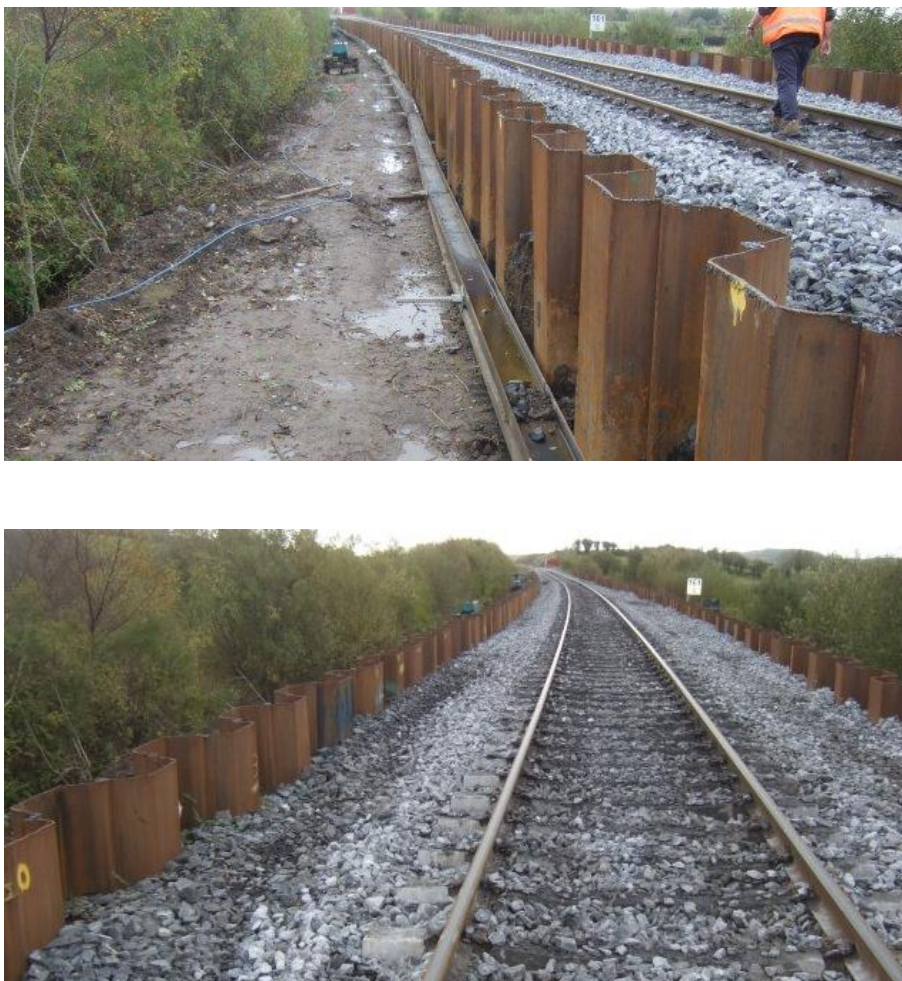
Fig. 2.26 – Aspeto geral da obra [7]
