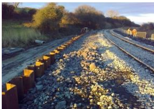
Fig. 2.28 – Aspeto geral da obra [8]
