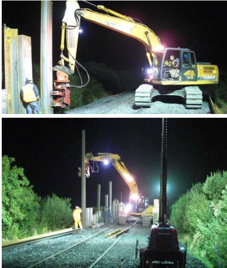
Fig. 2.27– Instalação das estacas prancha [7]
