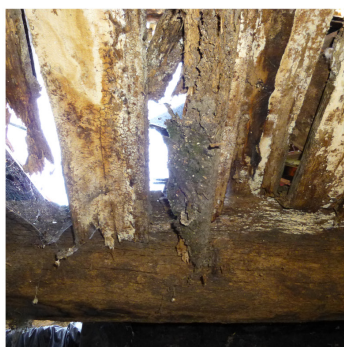
apodrecimento dos elementos por ação da humidade
