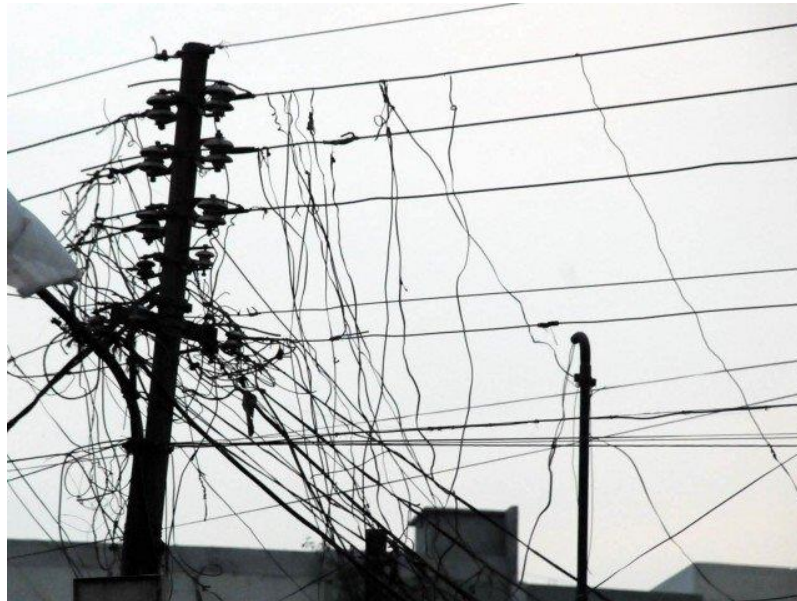
Figura 9 – Ligações diretas à rede de distribuição
