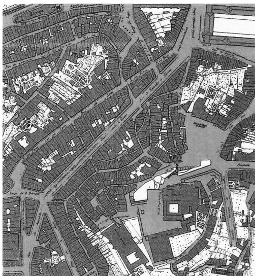
Fig. 48 Anos 40, depois da primeira fase de demolições
