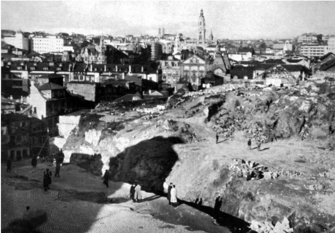
Fig. 50 Demolições, sem data
