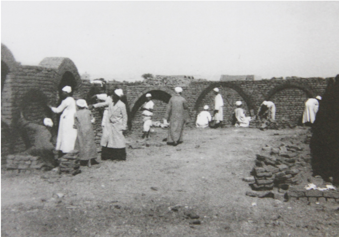
Figura 45 - Formação em obra, centro de aprendizagem para pedreiros.
