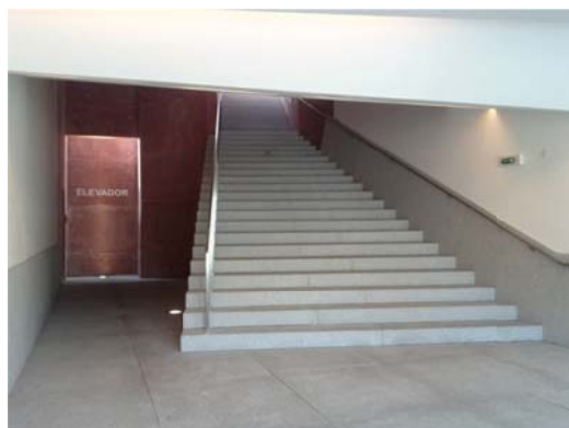
Fig. 57 – Passagem ao nível inferior
