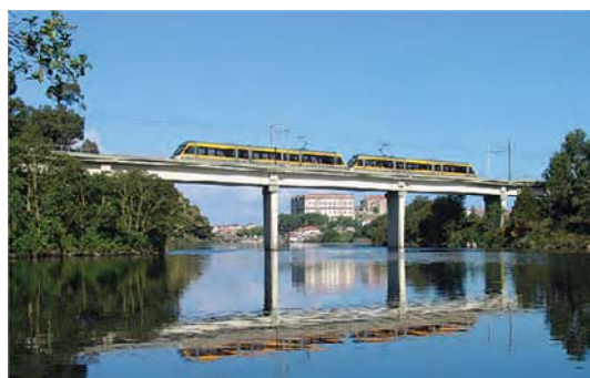
Fig. 13 – Ponte do metropolitano ligeiro
