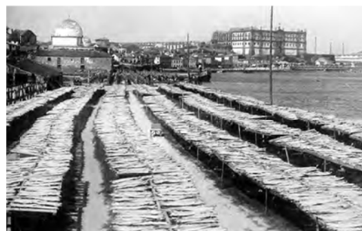
Fig. 27 – Praça das Descobertas anterior á intervenção
