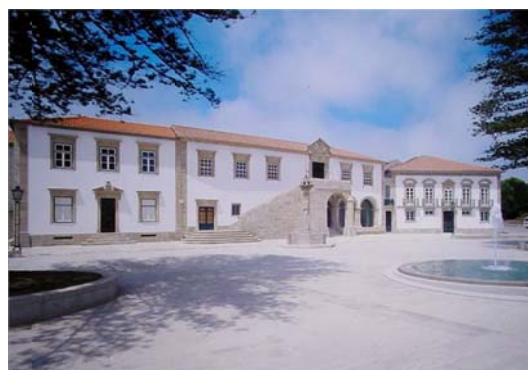
Fig. 79 – Fotografia posterior á intervenção
