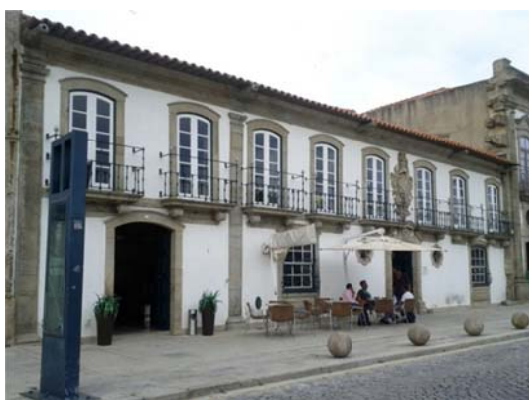
Fig. 46 – Fotografia da Fachada
