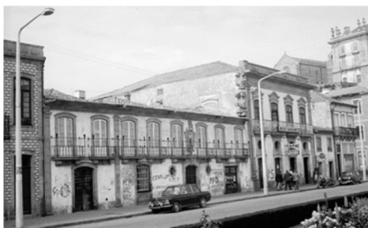
Fig. 44 – Fachada Principal em 1978
