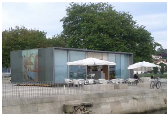
Fig. 91 – Centro de Acolhimento
