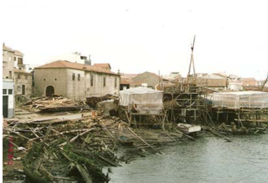
Fig. 83 – Exterior anterior à intervenção
