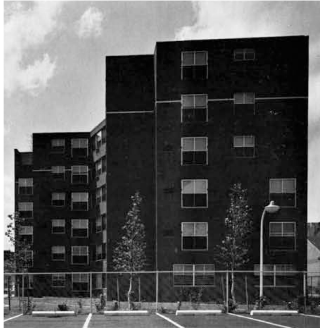
(78) Janelas convencionais na fachada lateral da Guild House (1961) | Filadélfia, E.U.A. | Robert Venturi (americano, 1925- )
