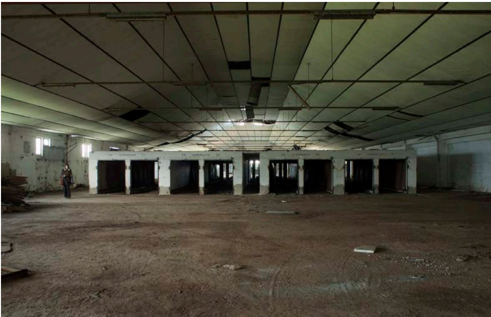
17. SNAB, armazém com 8 túneis de secagem artificial
