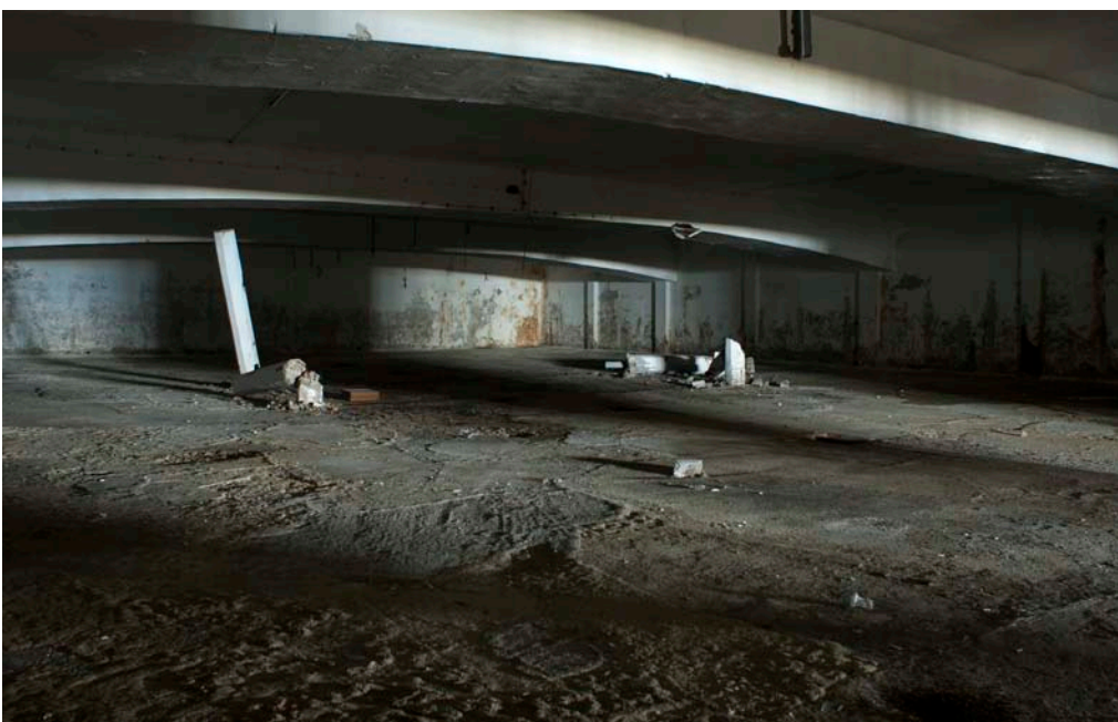
161. Armazém de Lavagem. Cobertura. Câmara frigorífica.
