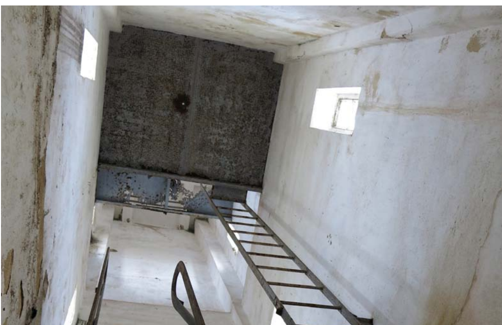
193. Vista desde os escritórios. Interior da torre
