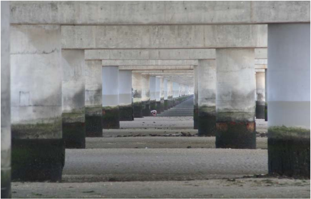
62. Areal sob a Ponte Vasco da Gama
