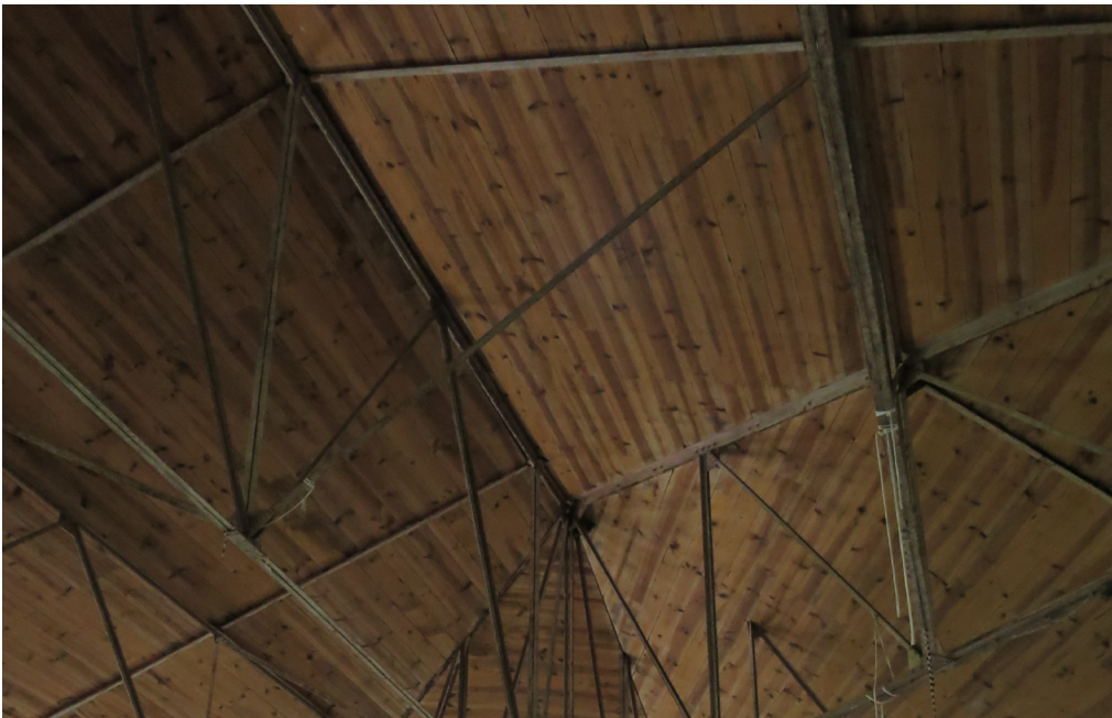
32. Pescal, estrutura metálica e revestimento em madeira
