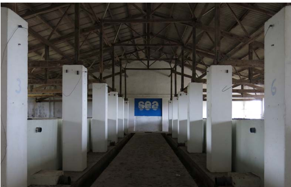
140. Câmara frigorífica. Passagem para túnel de secagem. Tanques para lagem de bacalhau
