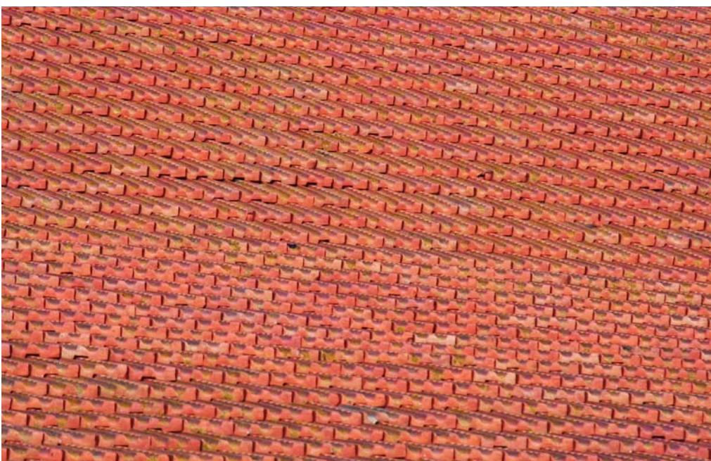
185. Cobertura, asnas em madeira e telha marselha
