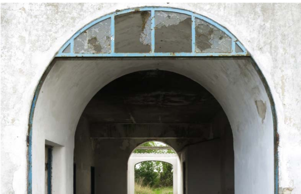
194. Depósito de água. Pormenor da cobertura em amianto. Entrada nos balneários
