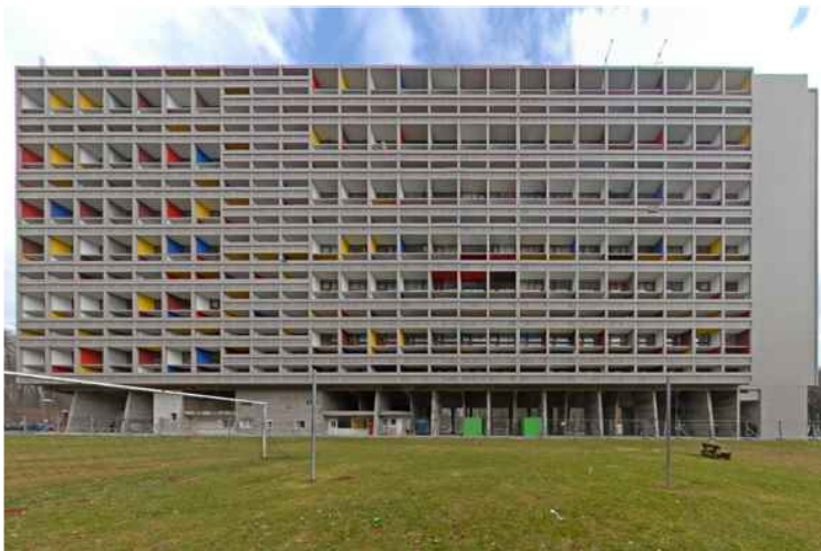
Figura 6 Unité D'habitation Firminy, 1965 Le Corbusier
