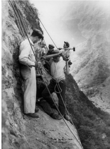
Figura 28 Construção das Levada
